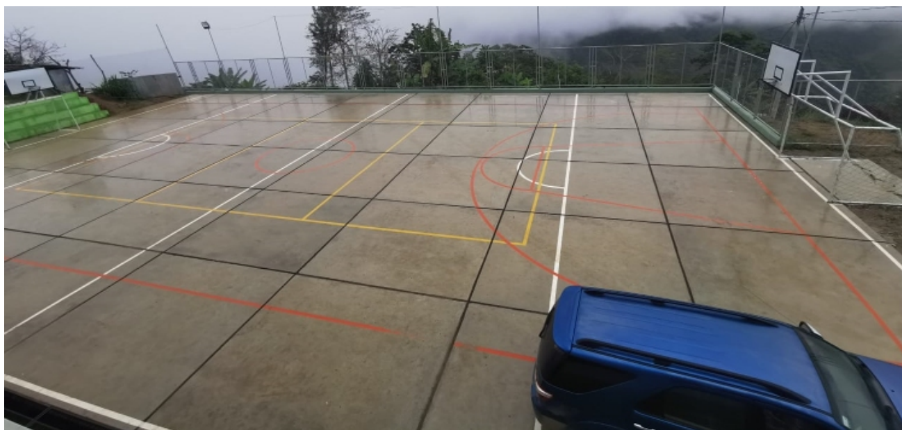
I.E N° 17587 “Augusto Vargas Alzamora”, Caserío Nueva Jerusalén, Distrito de Colasay, Provincia de Jaén
