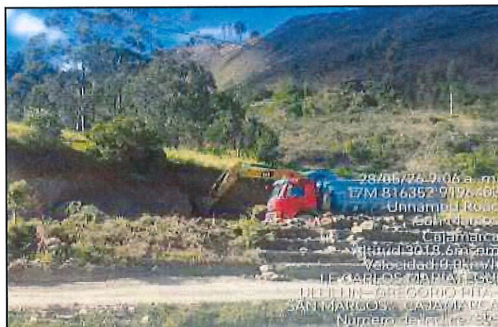
FOTO N° 03: SE EJECUTARON LOS TRABAJOS DE EXCAVACIÓN PARA LA CONSTRUCCIÓN DEL MURO DE CONTENCIÓN, MEDIANTE EL EMPLEO DE EXCAVADORA HIDRÁULICA Y VOLQUETE PARA LA REMOCIÓN Y EVACUACIÓN DEL MATERIAL EXCEDENTE, ALCANZANDO LAS DIMENSIONES Y NIVELES DE DISEÑO ESTABLECIDOS EN LOS PLANOS DEL PROYECTO, GARANTIZANDO LAS CONDICIONES NECESARIAS PARA LA POSTERIOR EJECUCIÓN DE LA CIMENTACIÓN DE LA ESTRUCTURA DE CONTENCIÓN.
