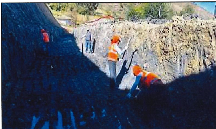
FOTO N° 03: SE EJECUTARON LOS TRABAJOS DE EXCAVACIÓN PARA LA CONSTRUCCIÓN DEL MURO DE CONTENCIÓN, MEDIANTE EL EMPLEO DE EXCAVADORA HIDRÁULICA Y VOLQUETE PARA LA REMOCIÓN Y EVACUACIÓN DEL MATERIAL EXCEDENTE, ALCANZANDO LAS DIMENSIONES Y NIVELES DE DISEÑO ESTABLECIDOS EN LOS PLANOS DEL PROYECTO, GARANTIZANDO LAS CONDICIONES NECESARIAS PARA LA POSTERIOR EJECUCIÓN DE LA CIMENTACIÓN DE LA ESTRUCTURA DE CONTENCIÓN.
