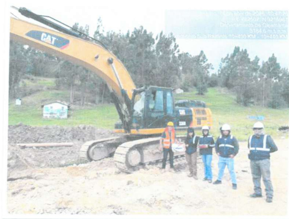
Ilustración 1. Inspección de Kit antiderrames.
