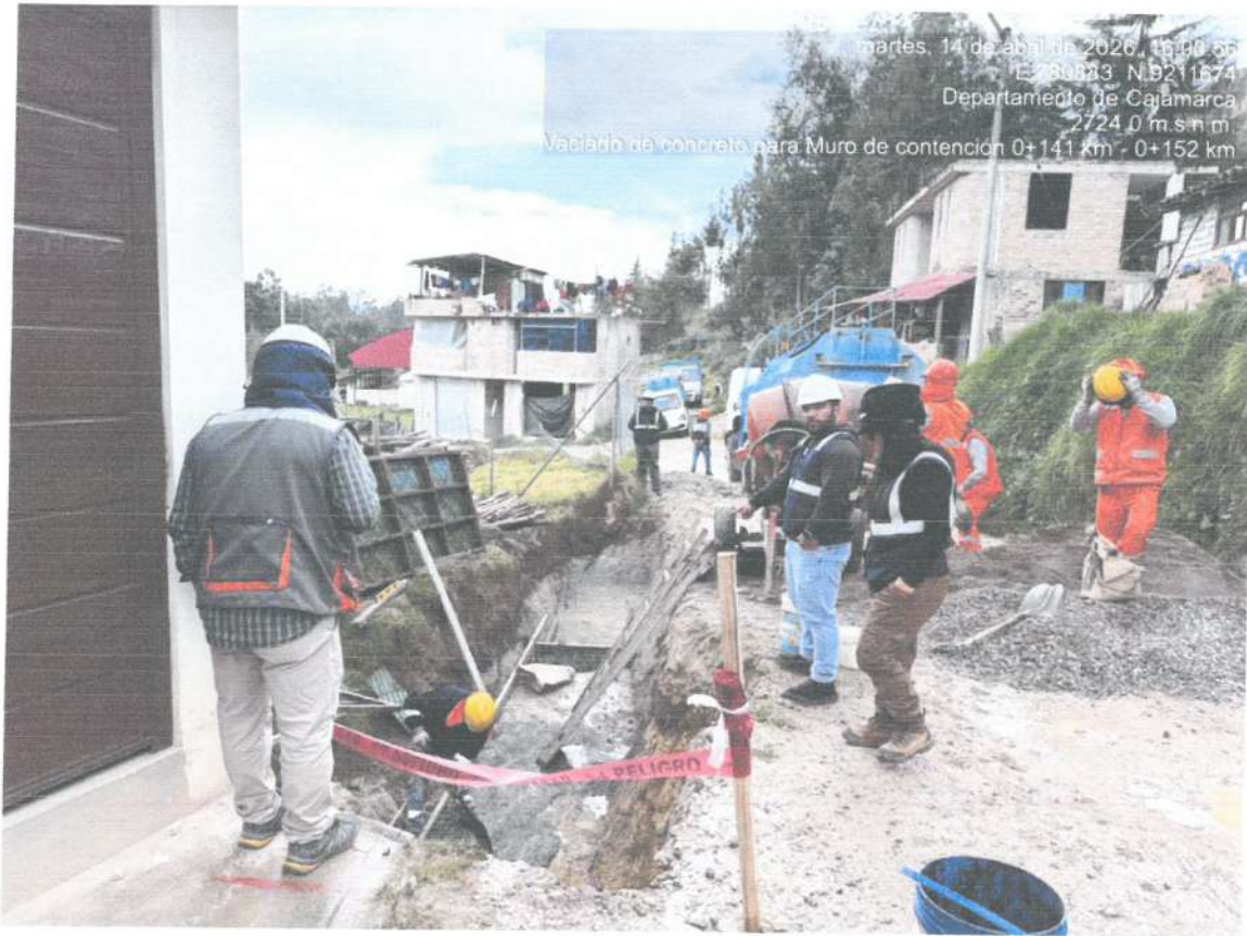
martes, 14 de abril de 2026, 18:00:08 E: 780882 N: 9211670 Departamento de Cajamarca 2721.9 m.s.n.m. Vaciado de concreto para Muro de contención 0+141 km - 0+152 km
