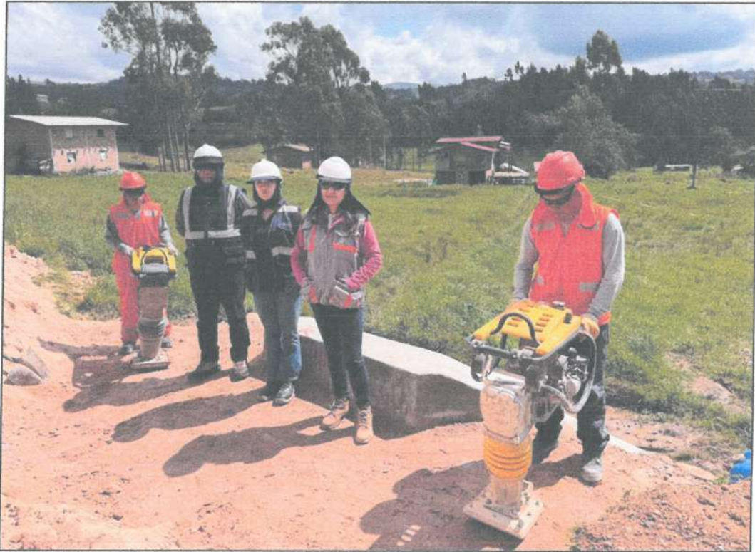
Fotografía N° 01: Control de compactación en relleno de cabezales de alcantarillas
