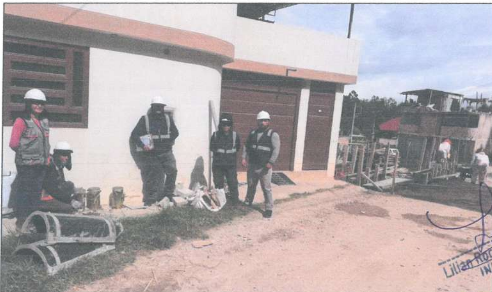
Fotografía N° 04: Elaboración de especímenes de concreto
