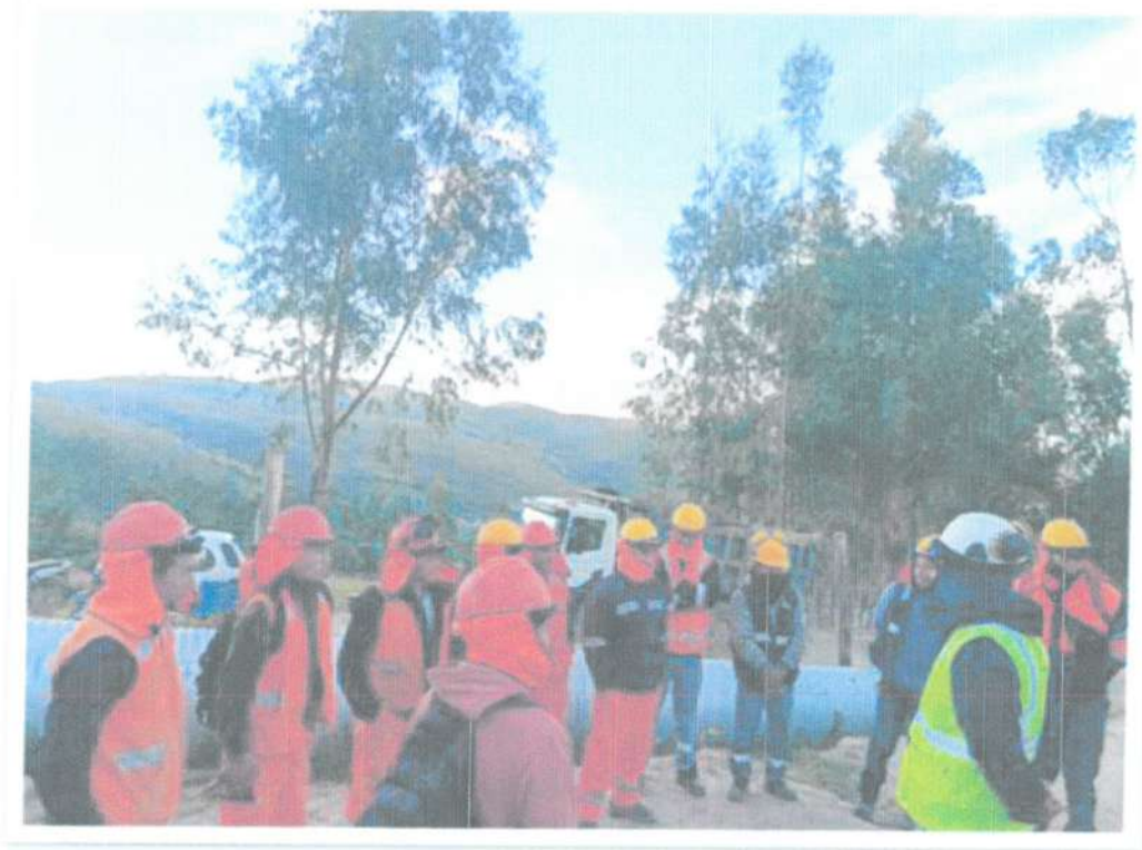
Ilustración 3. Inspección de charlas a personal de obra.
