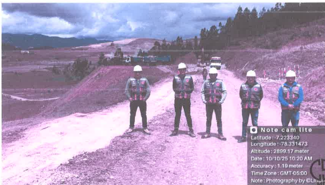
FOTOGRAFIA N° 12 : SE MUESTRA LA VERIFICACIÓN DE CONFORMACIÓN DE TERRAPLENES.
