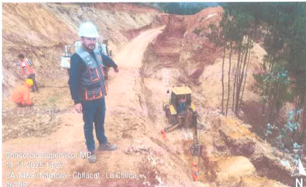
FOTOGRAFÍA N.º 01.- EXCAVACIÓN DE CIMIENTOS PARA MUROS DE CONCRETO CICLÓPEO Y CONCRETO ARMADO.
