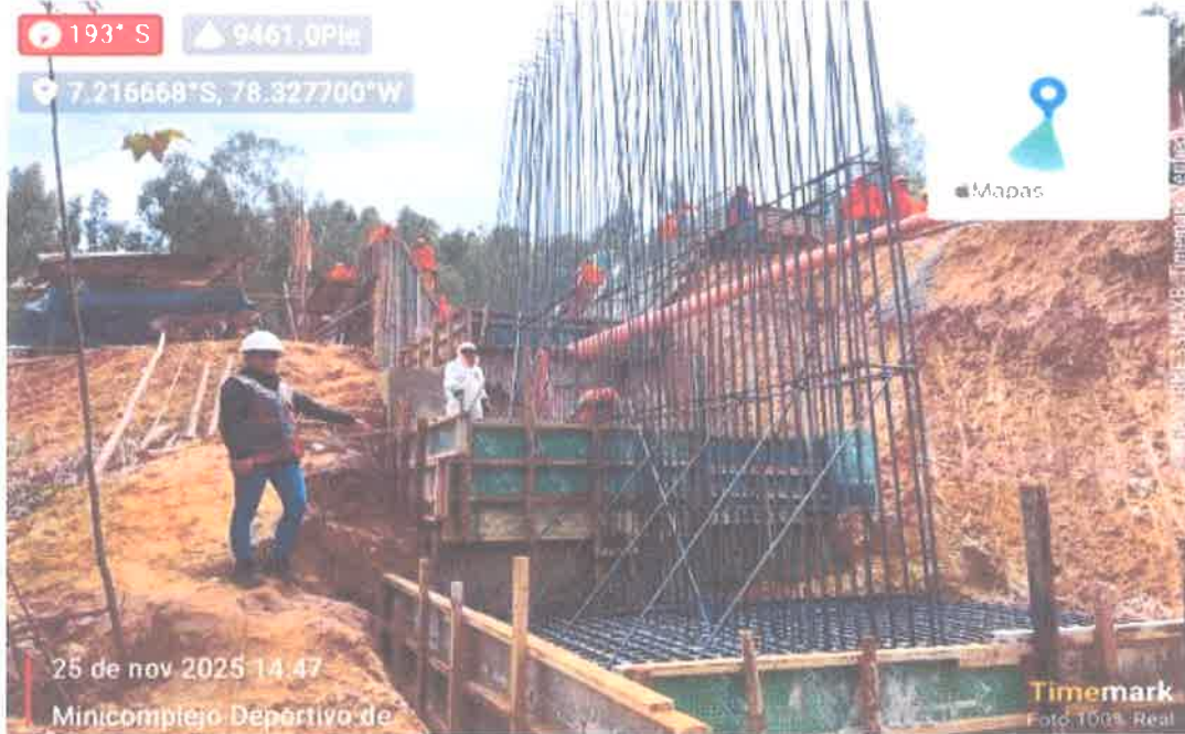
FOTOGRAFÍA N.º 03. COLOCACION DE ACERO PARA ZAPATA EN MURO DE CONCRETO ARMADO.
