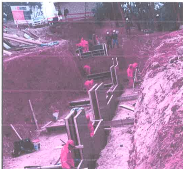
FOTOGRAFIA N° 07 : SE MUESTRA LA VERIFICACIÓN DE ENCOFRADO PARA VACIADO DE CONCRETO EN SOLADOS.
