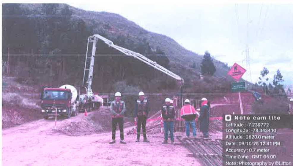
FOTOGRAFIA N° 02 : SE MUESTRA LA VERIFICACIÓN DEL VACIADO DEL CONCRETO EN PANTALLA DE MURO DE CONTENCIÓN.
