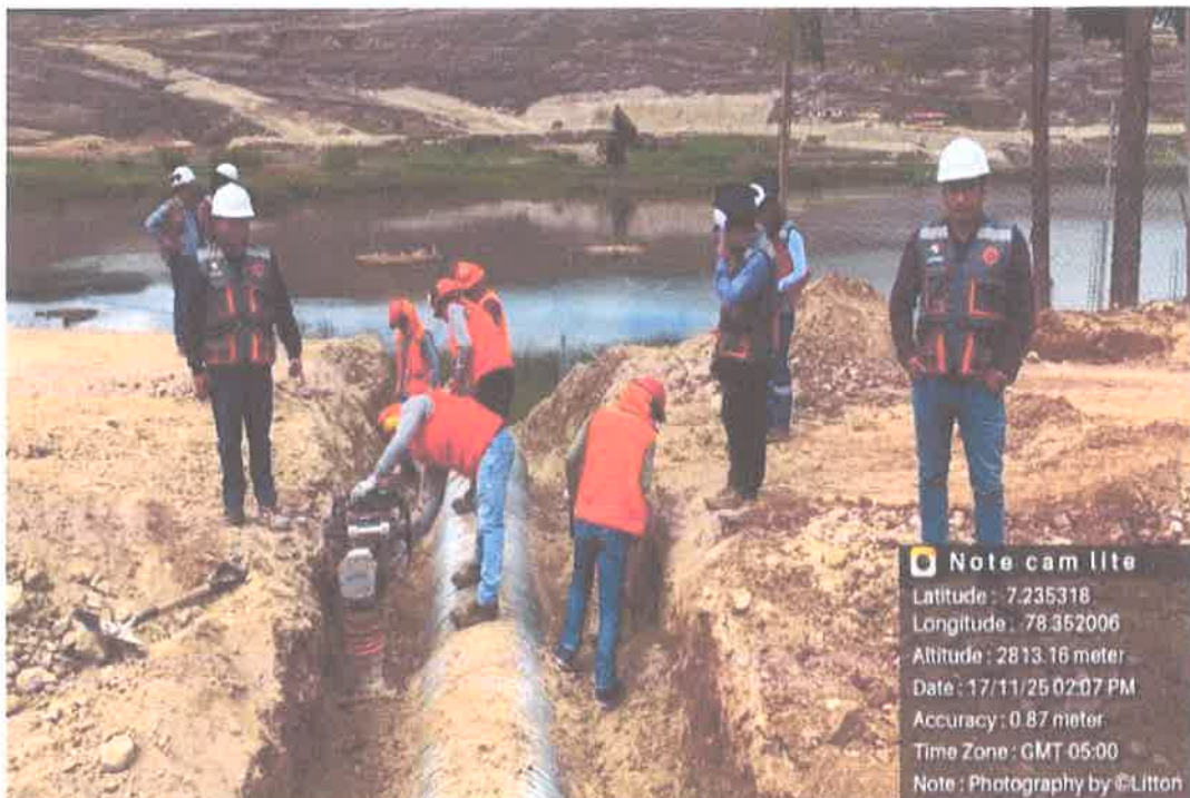
FOTOGRAFIA N.º 12.- RELLENO Y COMPACTACION CON MATERIAL DE PRÉSTAMO.
