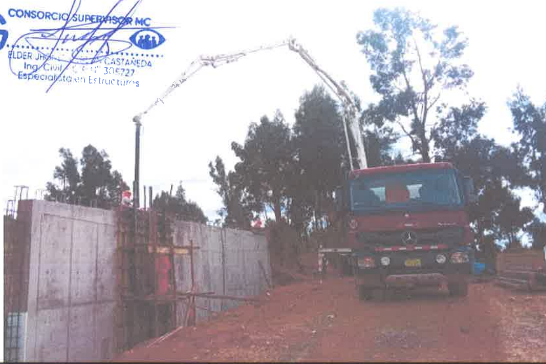
FOTOGRAFÍA N.º 08.- VACIADO DE PANTALLA EN MURO DE CONCRETO ARMADO.
