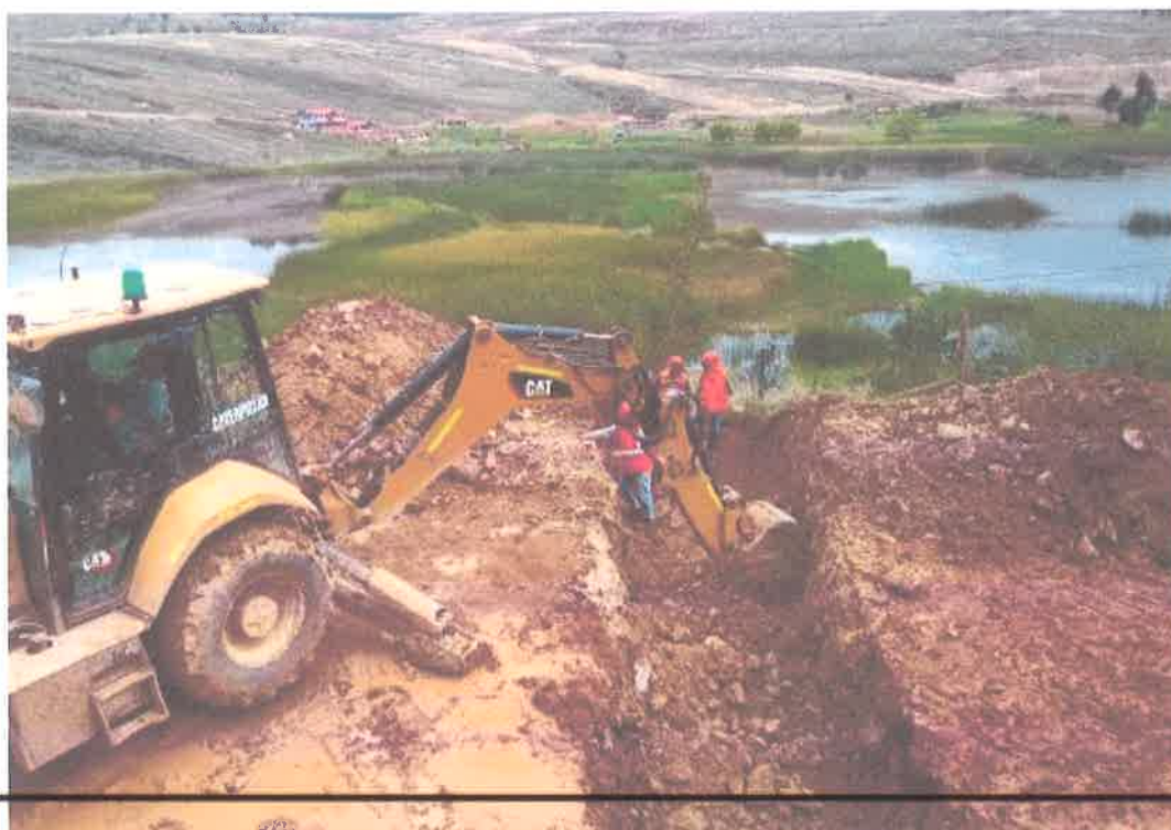
FOTOGRAFIA N.º 10.- EXCAVACIÓN PARA INSTALACION DE ALACANTARILLA.
