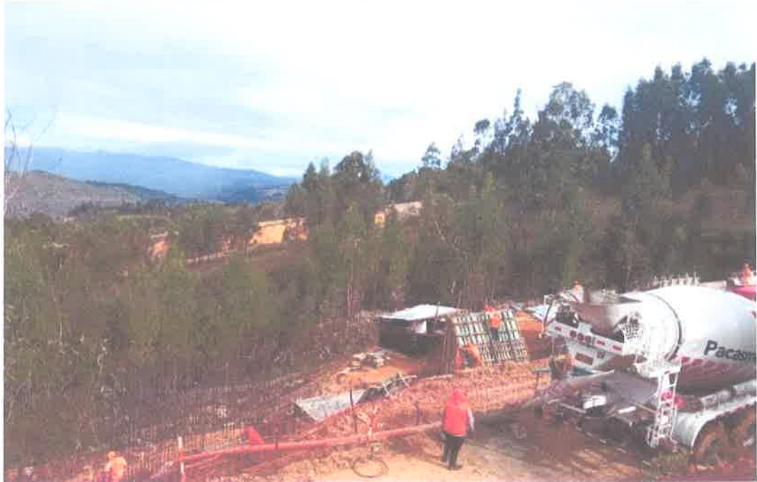
FOTOGRAFIA N.º 05.- VACIADO DE ZAPATA EN MURO DE CONTENCIÓN ARAMDO.
