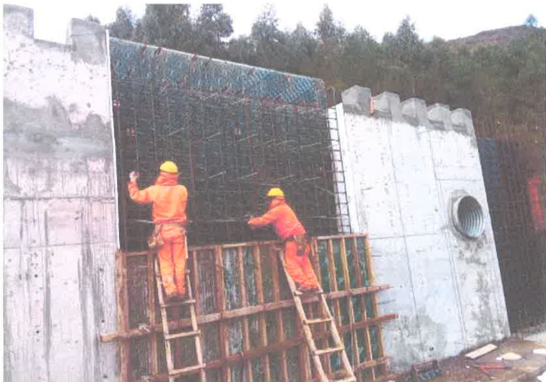
FOTOGRAFIA N.º 06.- TRABAJOS DE ENCOFRADO DE PANTALLA EN MURO DE CONTENCIÓN ARMADO.
