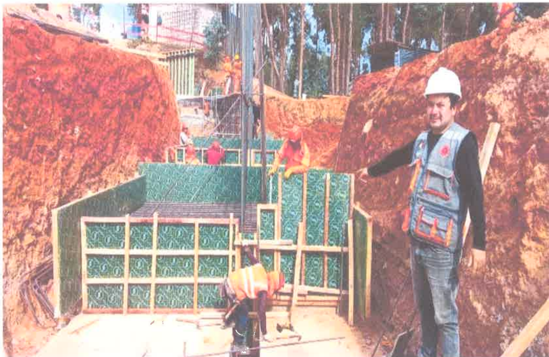
FOTOGRAFÍA N.º 04.- TRABAJOS DE ENCOFRADO DE ZAPATA EN MURO DE CONTENCIÓN ARMADO.
