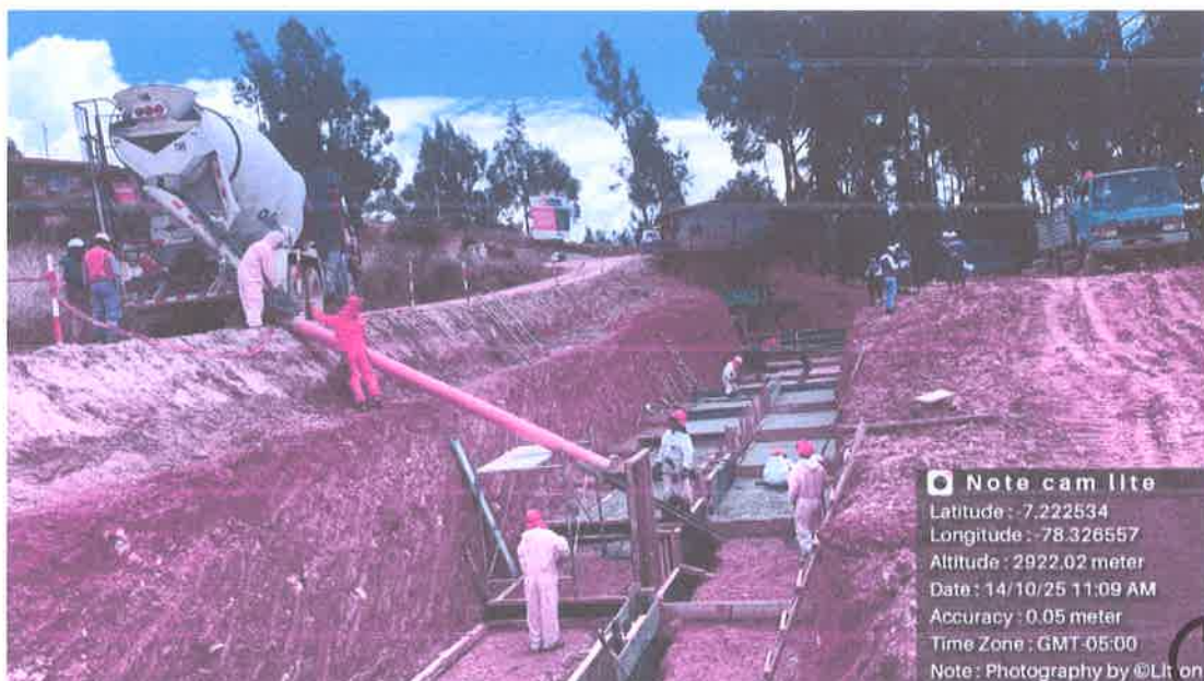
FOTOGRAFIA N° 08 : SE MUESTRA LA VERIFICACIÓN VACIADO DE CONCRETO EN SOLADO DE MURO DE CONTENCIÓN.
