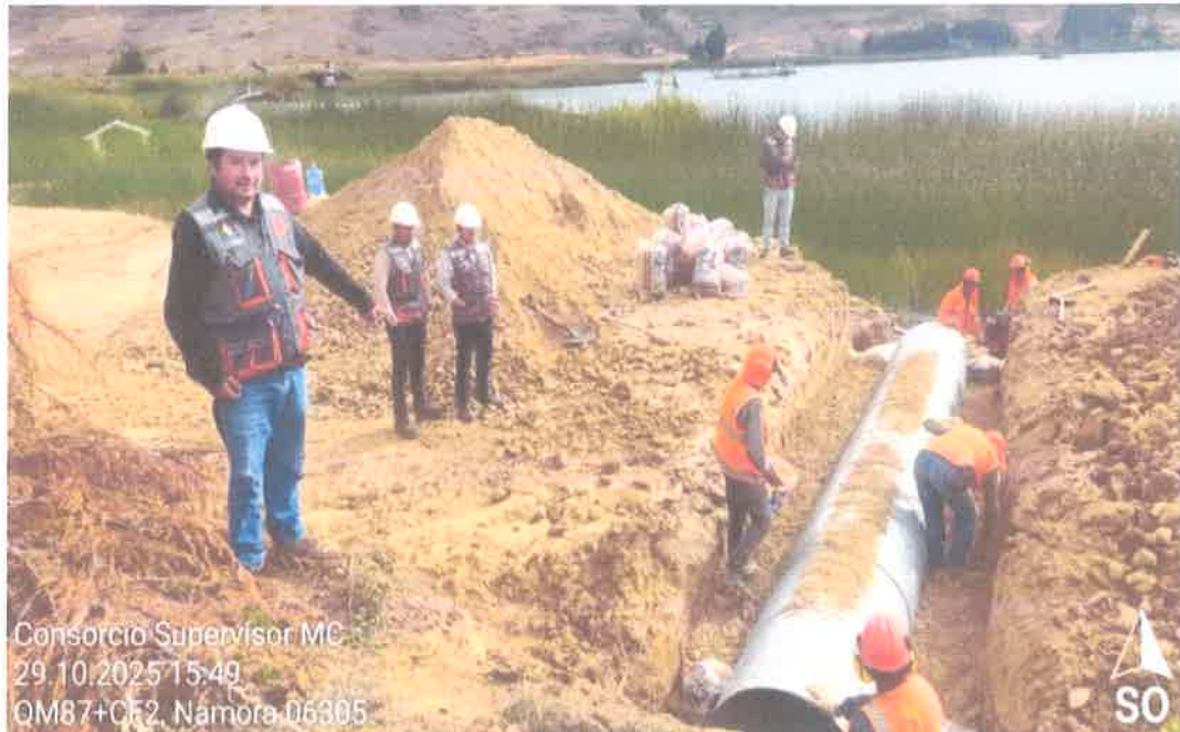
FOTOGRAFIA N.º 11.-INSTALACIÓN DE ALCANTARILLA TMC”.
