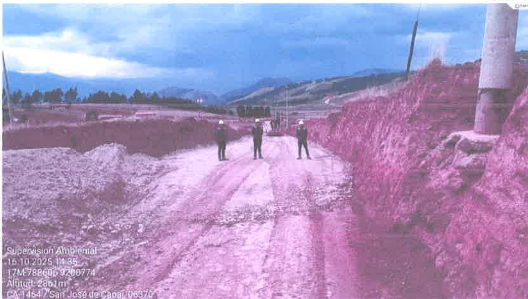
FOTOGRAFIA N° 05 : SE MUESTRA LA VERIFICACIÓN DE LOS TRABAJOS DE MEJORAMIENTO DE SUBRASANTE.
