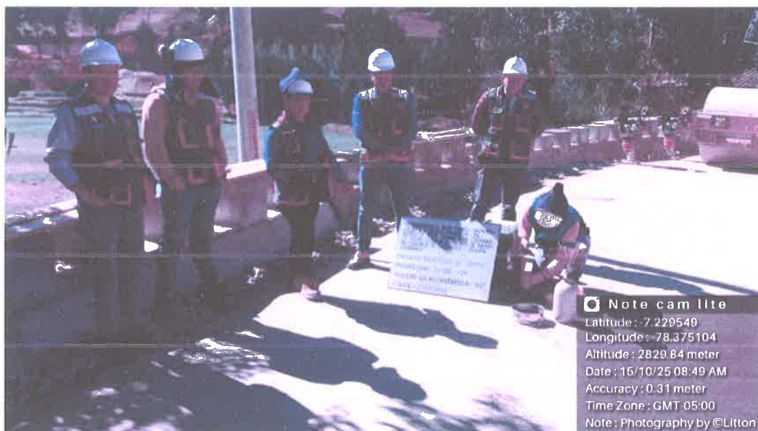
FOTOGRAFIA N° 04: SE MUESTRA EL LA VERIFICACIÓN DEL GRADO DE COMPACTACIÓN, MEDIANTE EL ENSAYO DE CONO DE ARENA.
