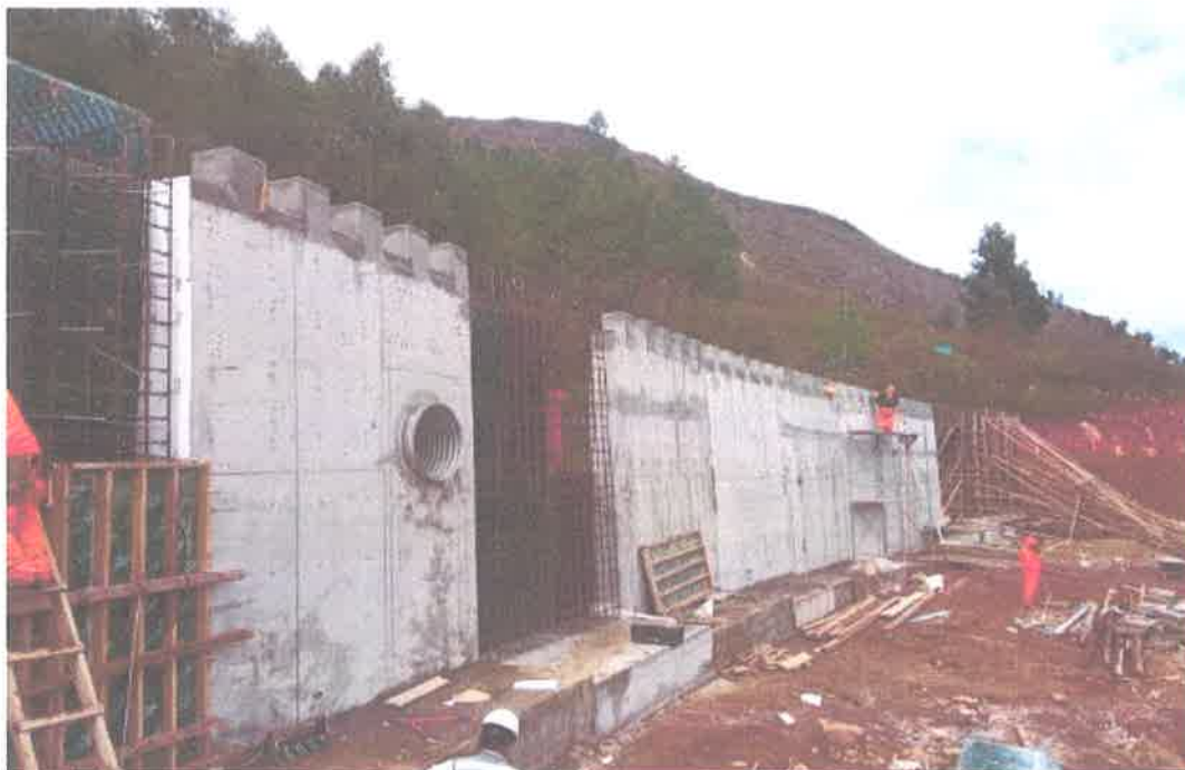
FOTOGRAFIA N.º 09.- COLOCACIÓN DE ACERO TRANSVERSAL DE PANTALLA EN MURO DE CONTENCIÓN ARMADO.
