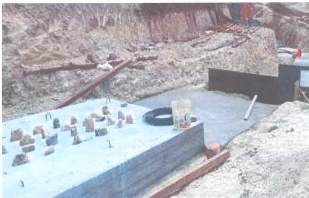
FOTOGRAFÍA N.º 02.- TRABAJOS REALIZADOS EN ZAPATAS DE CONCRETO CICLÓPEO / SOLADOS / ENCOFRADOS EN MURO.
