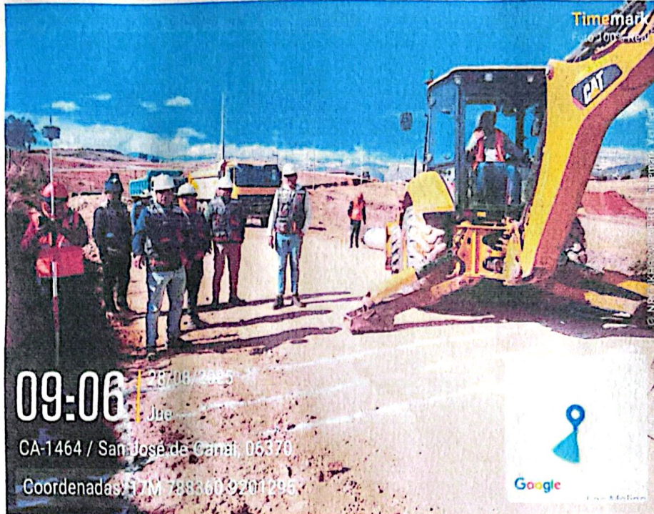
FOTOGRAFIA N° 07 : SE MUESTRA LA VERIFICACIÓN DE TRAZOS PARA LA COLOCACIÓN DE ALCANTARILLAS PARA EL DRENAJE.
