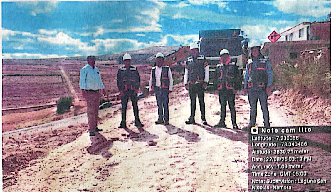
FOTOGRAFIA N° 11 : SE MUESTRA LA VERIFICACIÓN DEL ENSANCHE EN LA CARRETERA.
