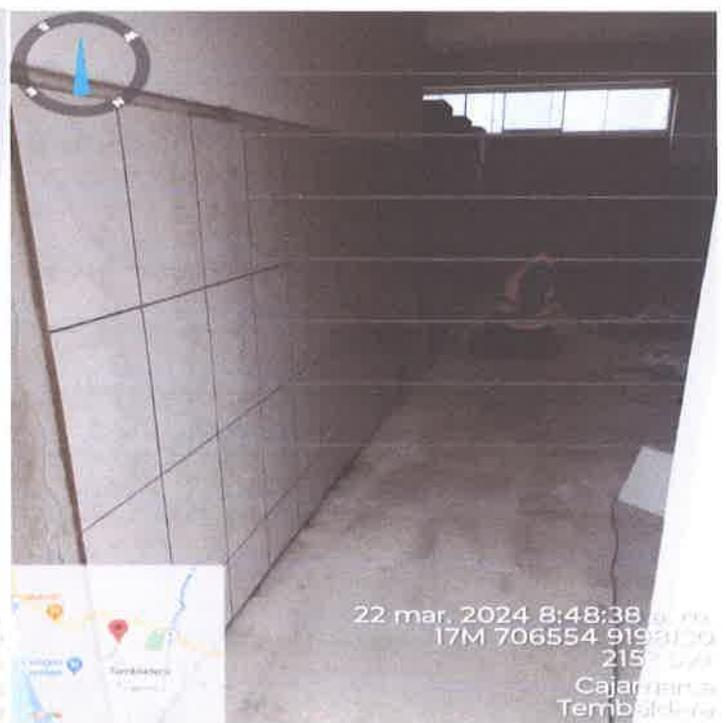
Fotografía N°06. Vista de la colocación de cerámicas a los baños
