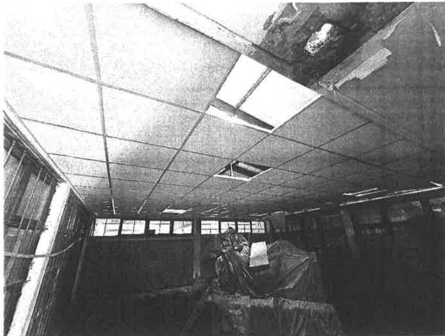
Imagen 5: Colocación de cielo raso con baldosas en el ambiente de REGISTROS E INSCRIPCIONES. (Fuente Propia)
