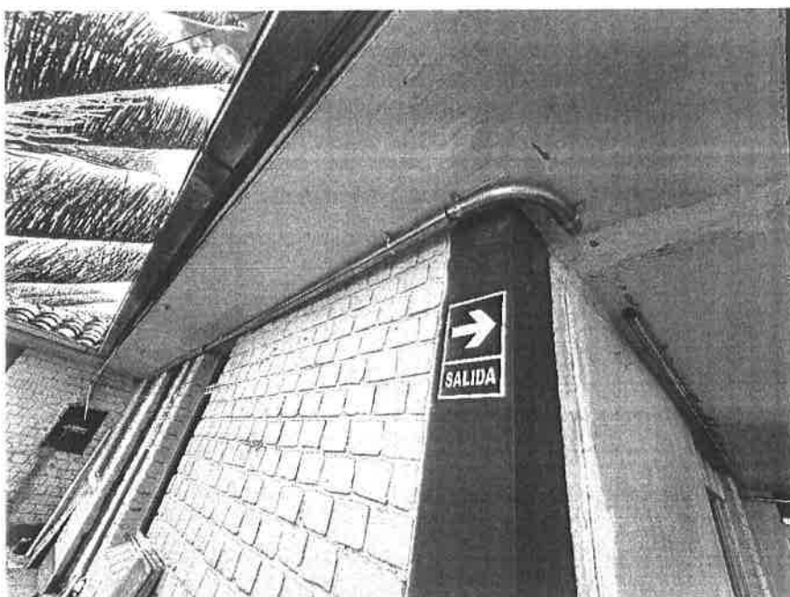
Imagen 12: Colocación de tubería galvanizada para alojar cables eléctricos. (Fuente Propia)
