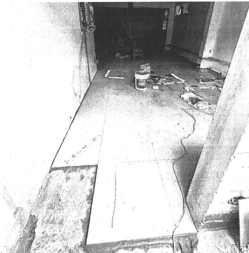
Imagen 6: Asentado de porcelanato en el ambiente de ARCHIVO CENTRAL. (Fuente Propia)
