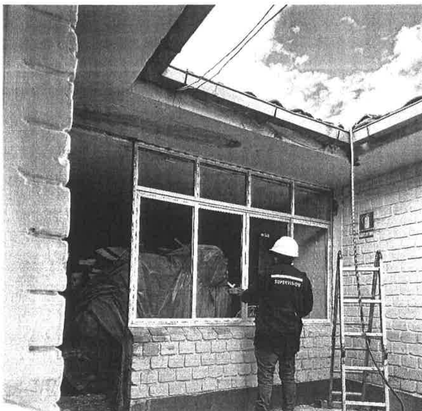
Imagen 8: Supervisión en la colocación de marco de aluminio en ventana del ambiente OFICINA 4. (Fuente Propia)
