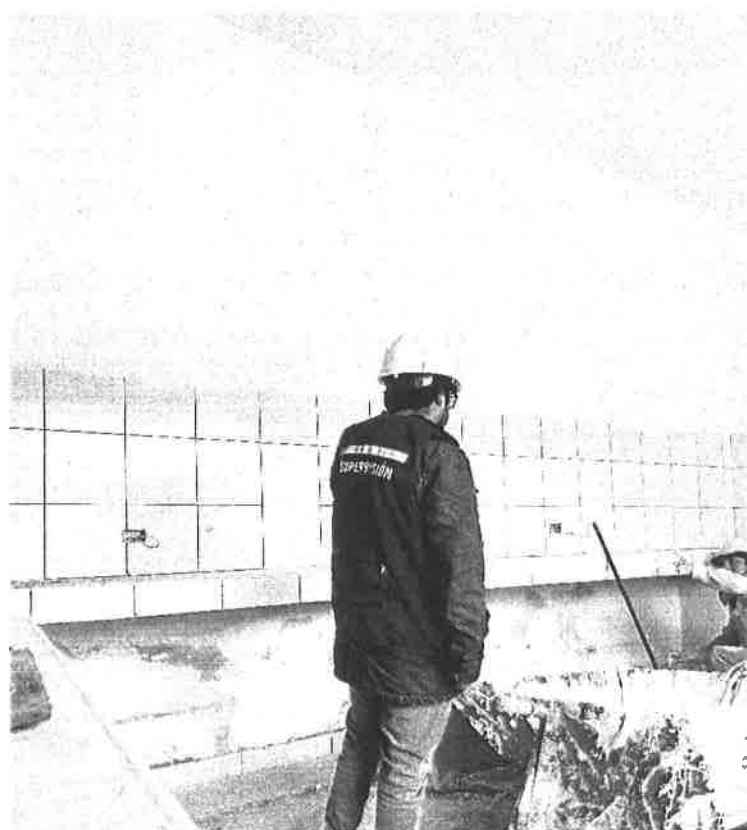
Imagen 10: Supervisión en pintura del ambiente de COCINA (Fuente Propia)
