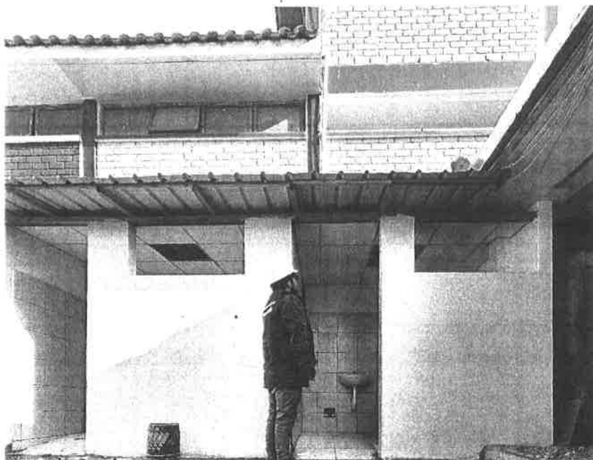
Imagen 2: Corroborando la instalación del cielo raso en baño de discapacitados hombre y mujer. (Fuente Propia).
