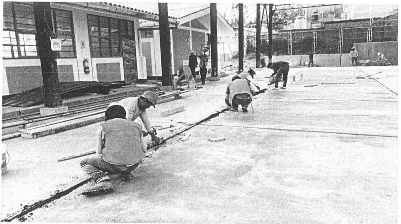
Fotografía N°06: Verificación de colocación de junta de dilatación asfáltica en plataforma deportiva.
