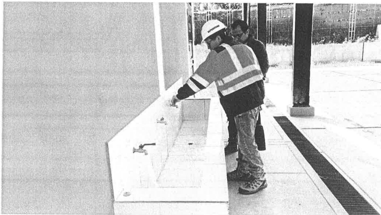
Fotografía N°09: Verificación de funcionamiento de tuberías y accesorios de agua.
