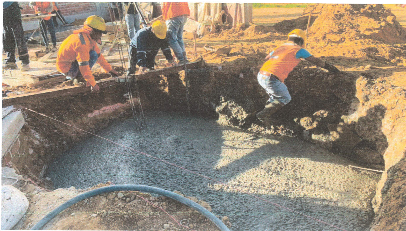
Fotografía N°03: Verificación y control de vaciado de concreto en zapata de ingreso.
