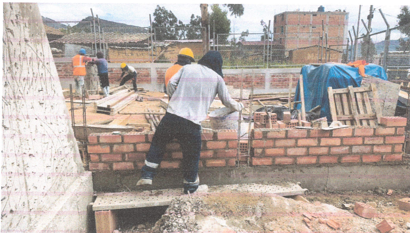
Fotografía N°04: Verificación de alzado de muro de ladrillo en cerco perimétrico.
