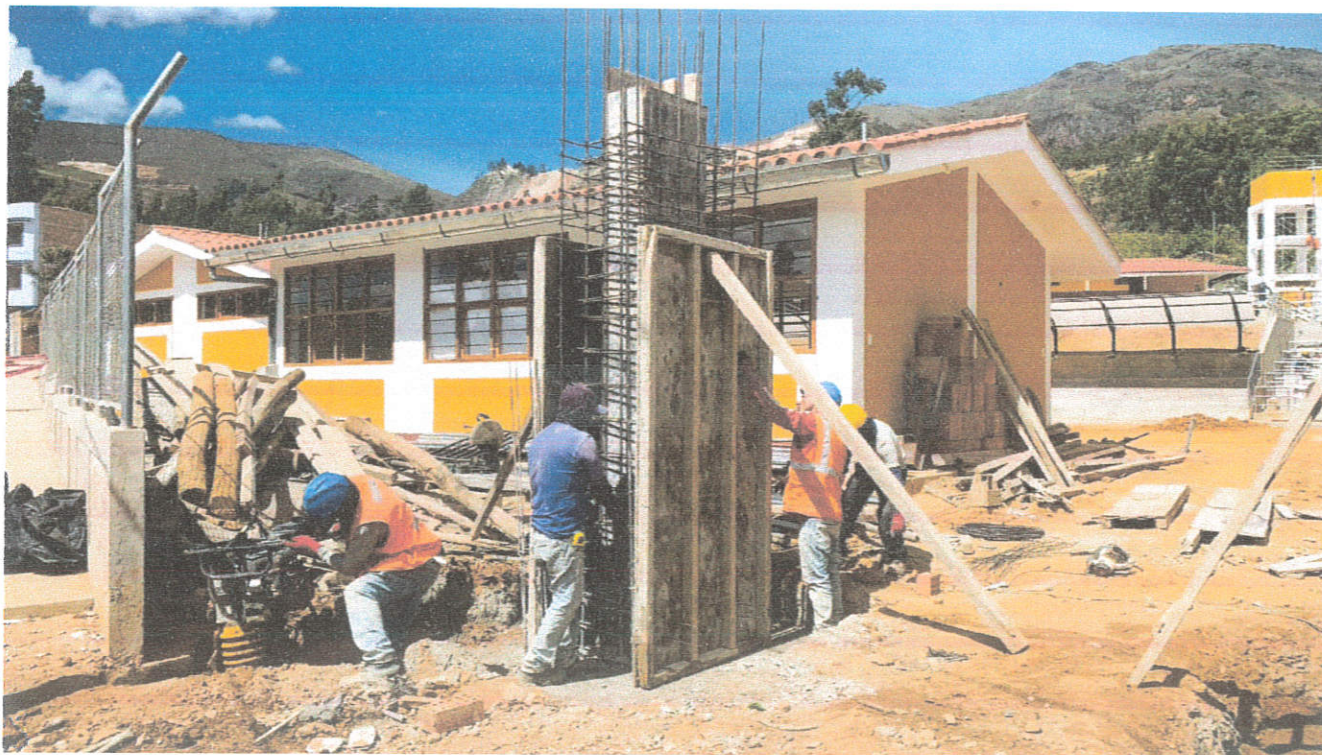
Fotografía N°01: Verificación de encofrado en columna de ingreso.
