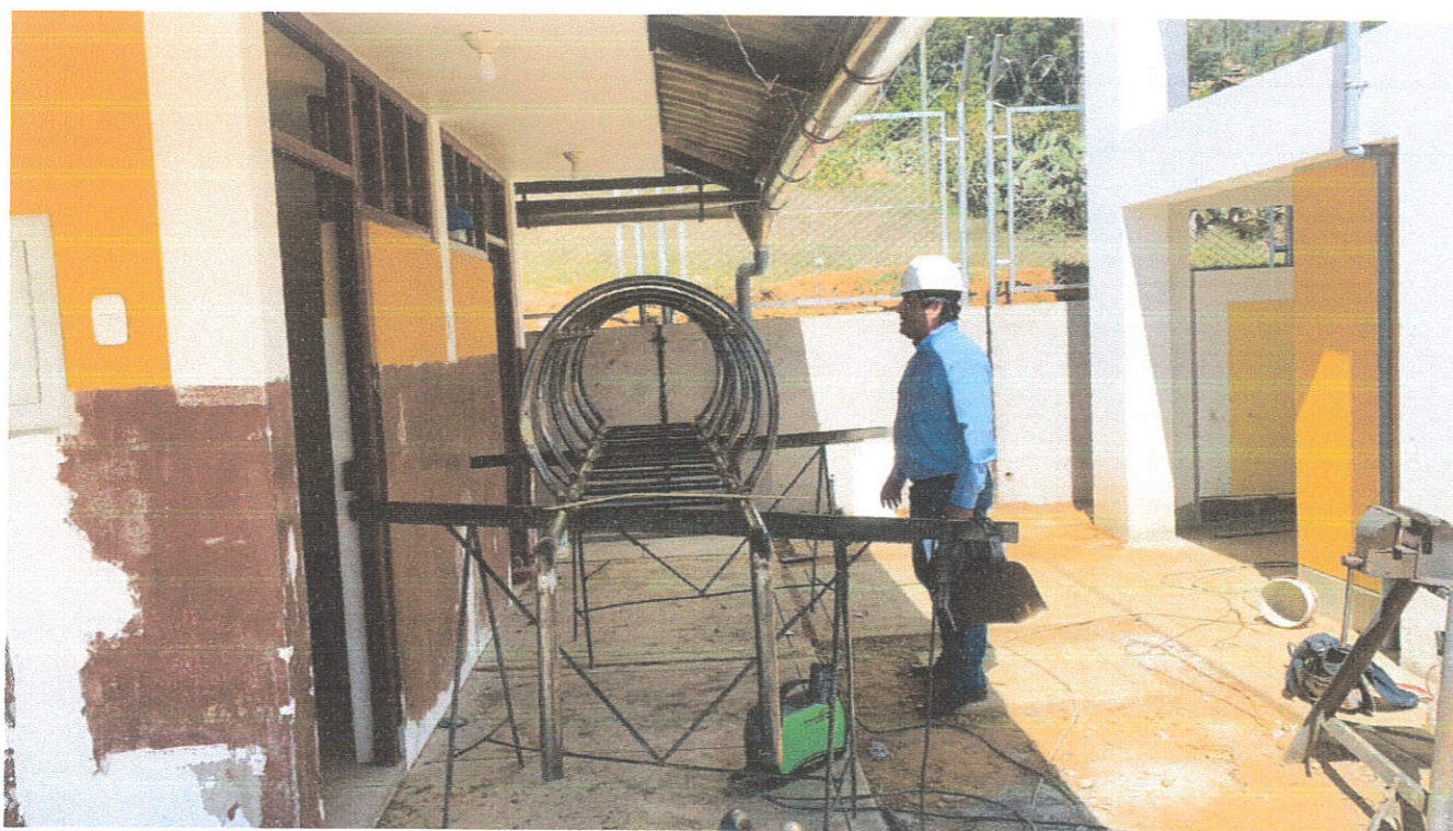
Fotografía N°18: Verificación de construcción de escalera de gato para tanque elevado y cisterna.
