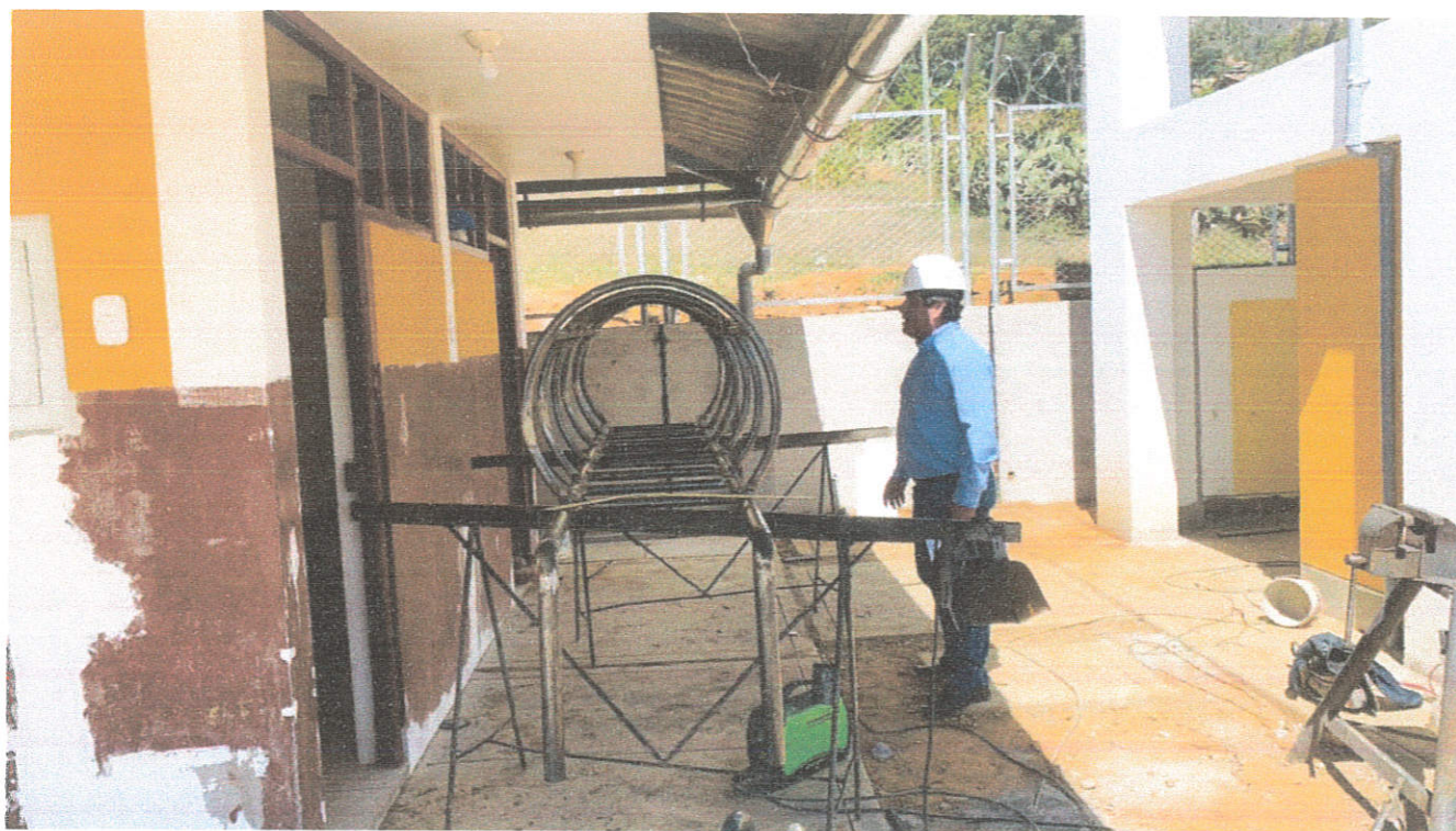
Fotografía N°04: Verificación de construcción de escalera de gato para tanque elevado.
