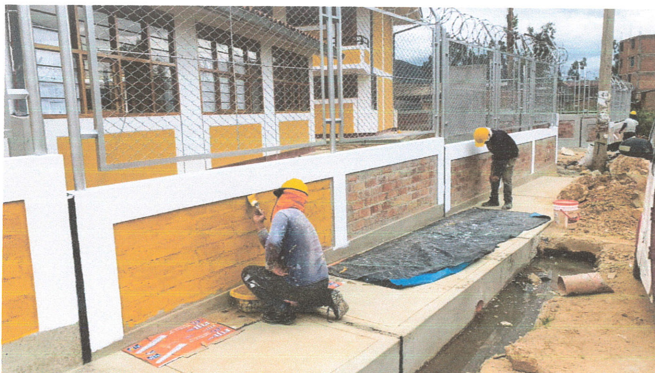
Fotografía N°14: Verificación de pintado exterior de cerco perimétrico mixto.
