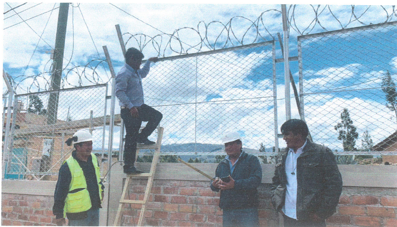
Fotografía N°13: Verificación de colocación de concertina con representantes de la comunidad.
