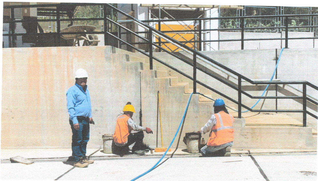
Fotografía N°17: Verificación de colocación de asfalto en juntas exteriores.
