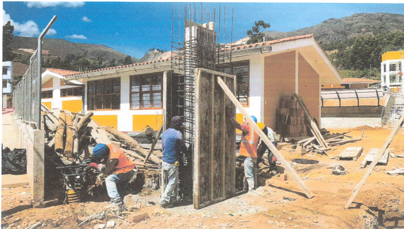
Fotografía N°05: Verificación de encofrado en columna de portada de ingreso.
