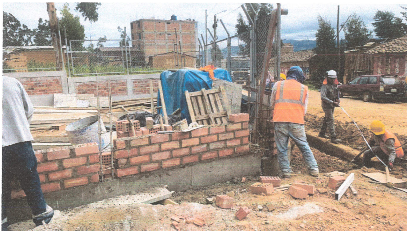
Fotografía N°06: Verificación de alzado de muro de ladrillo en cerco perimétrico.
