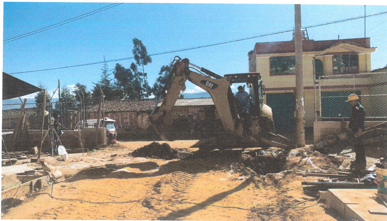
Fotografía N°01: Verificación de trazo, replanteo y excavación de portada e ingreso.
