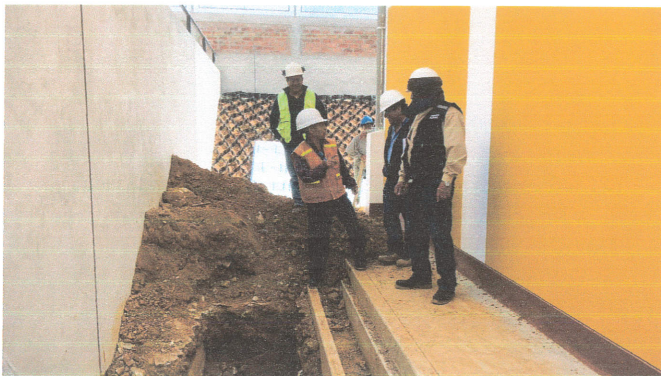
Fotografía N°10: Verificación de construcción de pozo a tierra.
