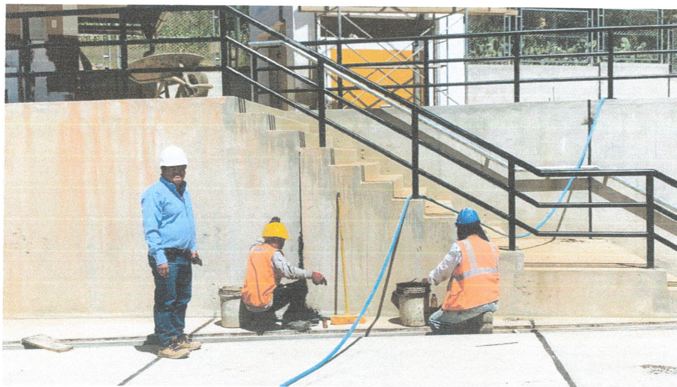
Fotografía N°05: Verificación de juntas de dilatación asfálticas en exteriores.
