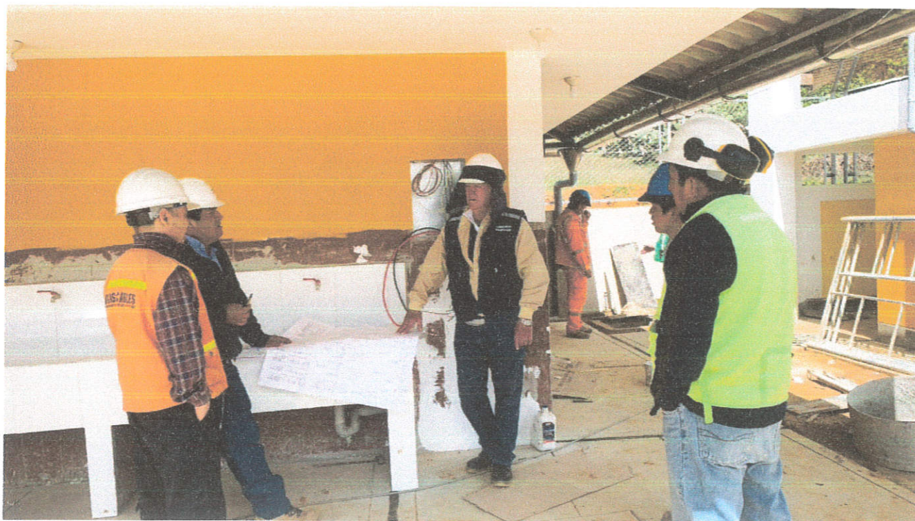
Fotografía N°09: Verificación de cableado eléctrico exterior con especialistas en eléctricas y residente.
