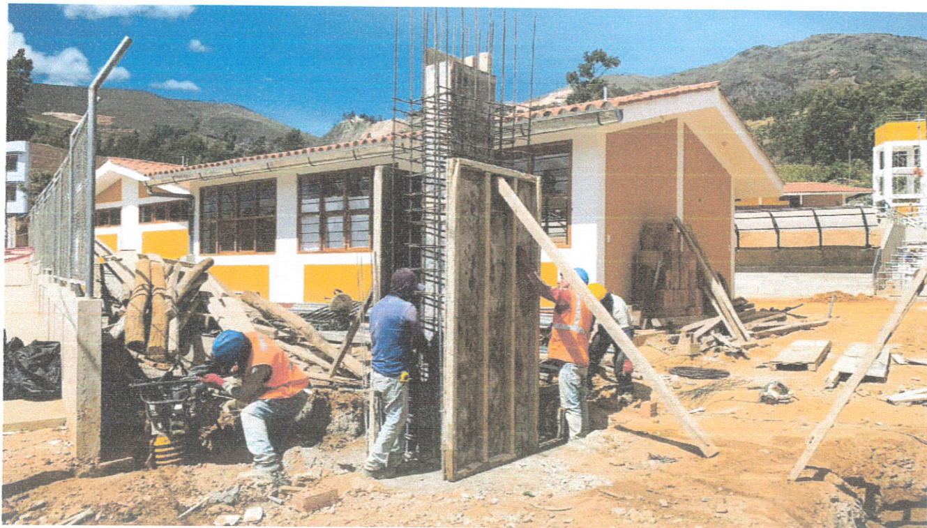
Fotografía N°01: Verificación de encofrado en columna de ingreso.
