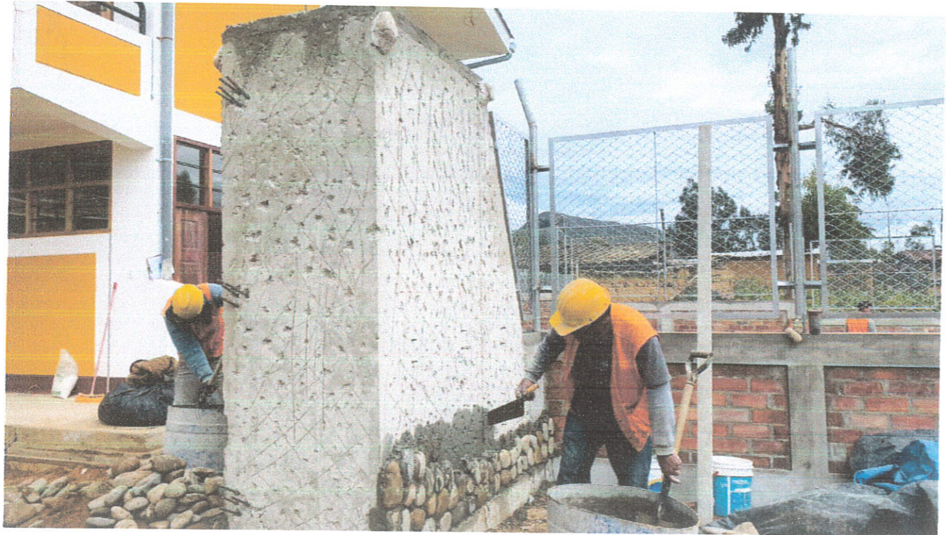
Fotografía N°07: Verificación de colocación de empedrado en columna de portada de ingreso.
