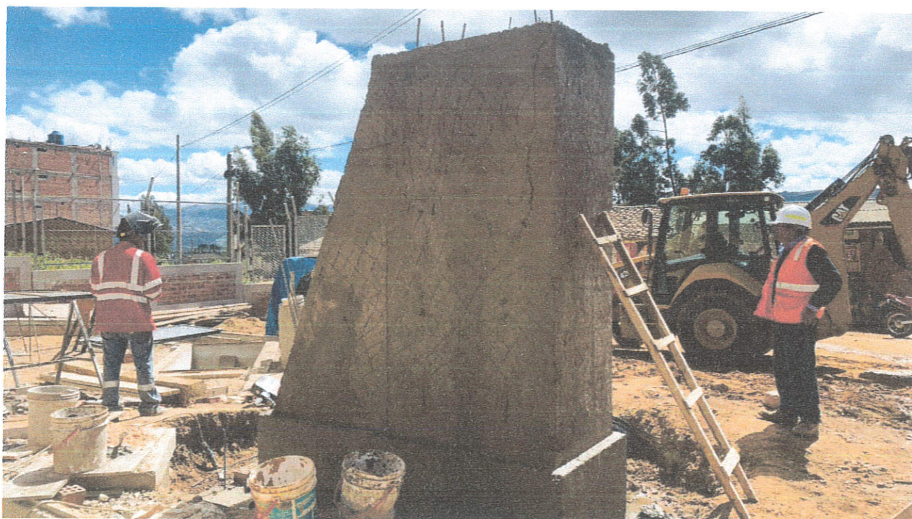
Fotografía N°02: Verificación de muro de mampostería de piedra en ingreso.
