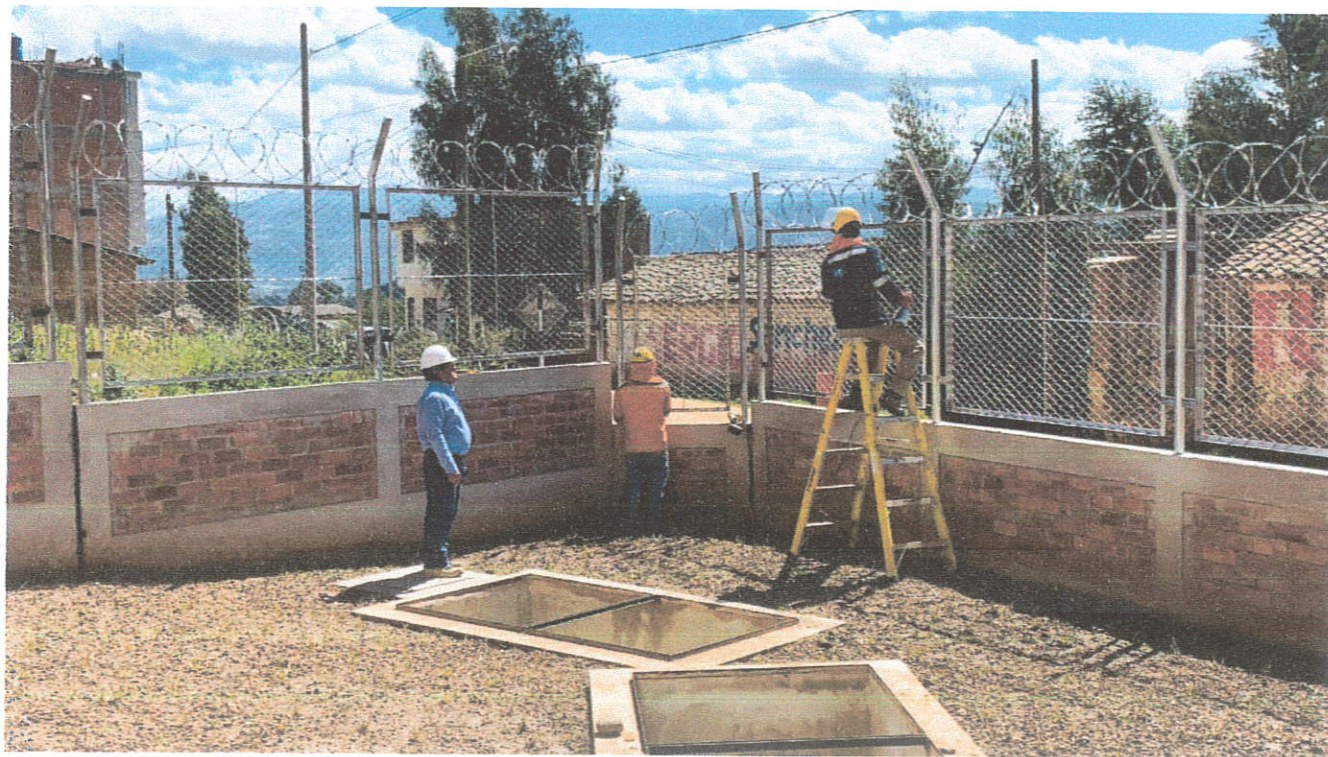
Fotografía N°15: Verificación de pintado de parantes y malla metálica en cerco perimétrico mixto.
