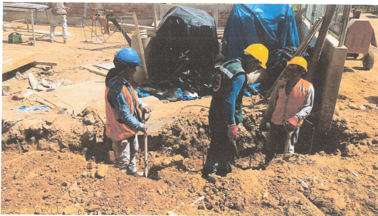
Fotografía N°02: Verificación de colocación de afirmado y compactación en cerco perimétrico de ingreso.
