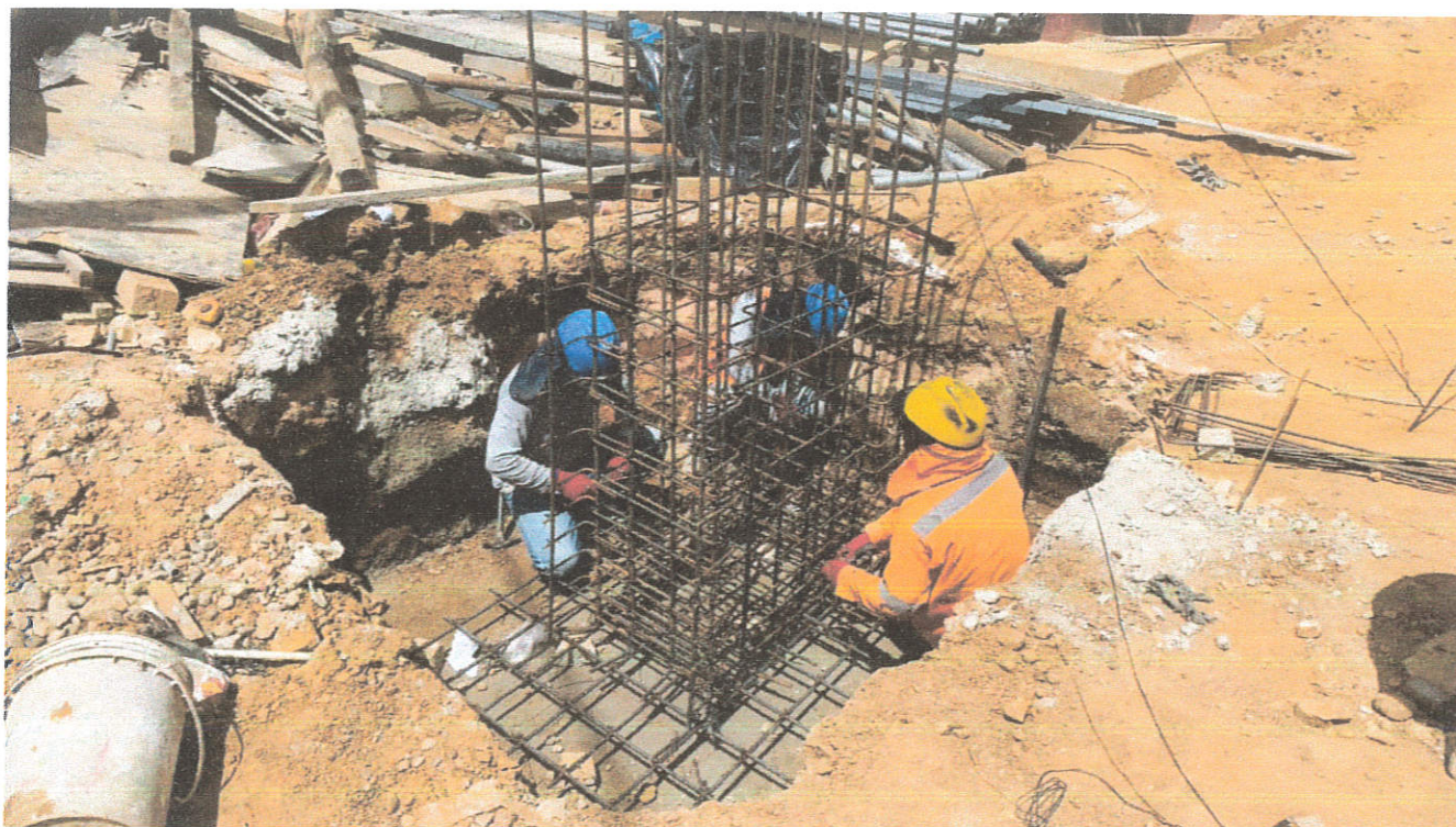
Fotografía N°04: Verificación de habilitación de acero en columnas de portada de ingreso.
