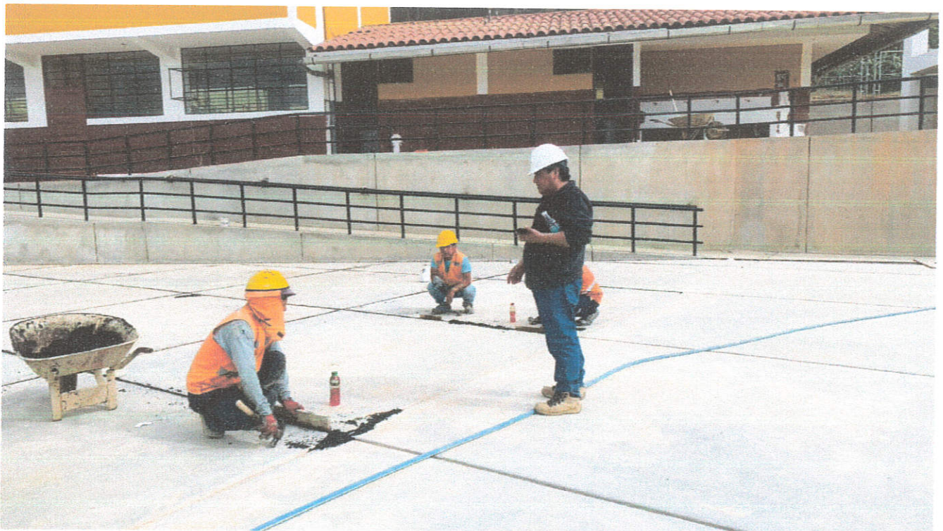
Fotografía N°08: Verificación de colocación de asfalto en juntas exteriores.
