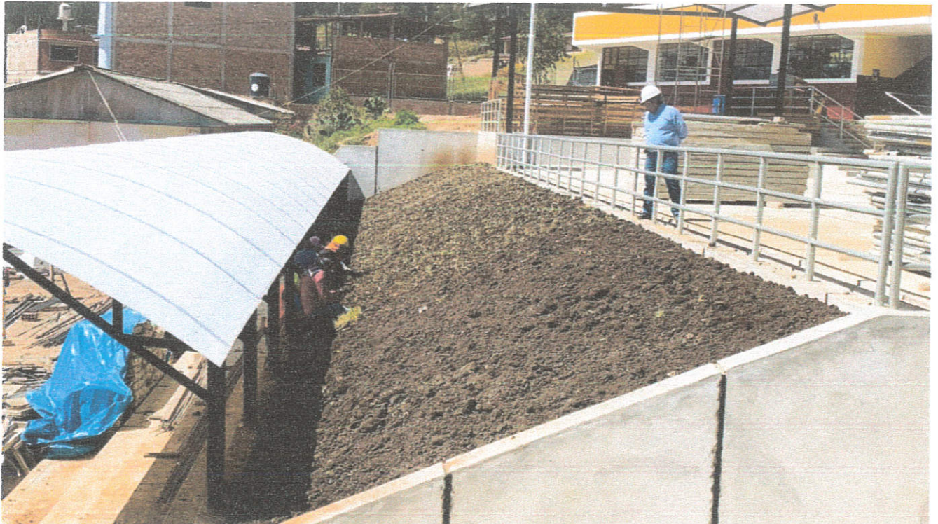
Fotografía N°06: Verificación de colocación y sembrado de áreas verdes.
