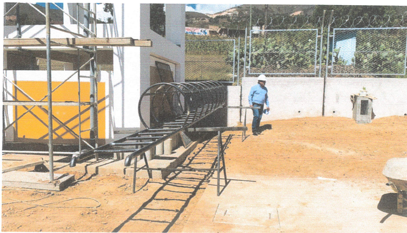
Fotografía N°03: Verificación de construcción de escalera de gato para tanque elevado.
