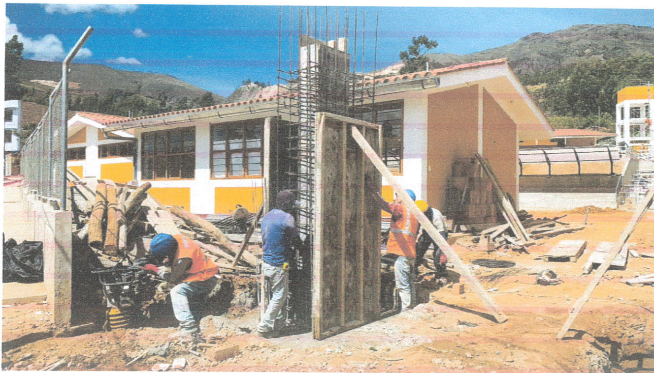
Fotografía N°01: Verificación de encofrado en columna de ingreso.
