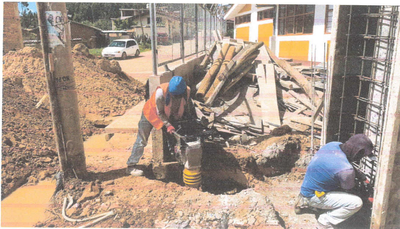
Fotografía N°03: Verificación de compactación de afirmado en cimentación de muro de cerco perimétrico.
