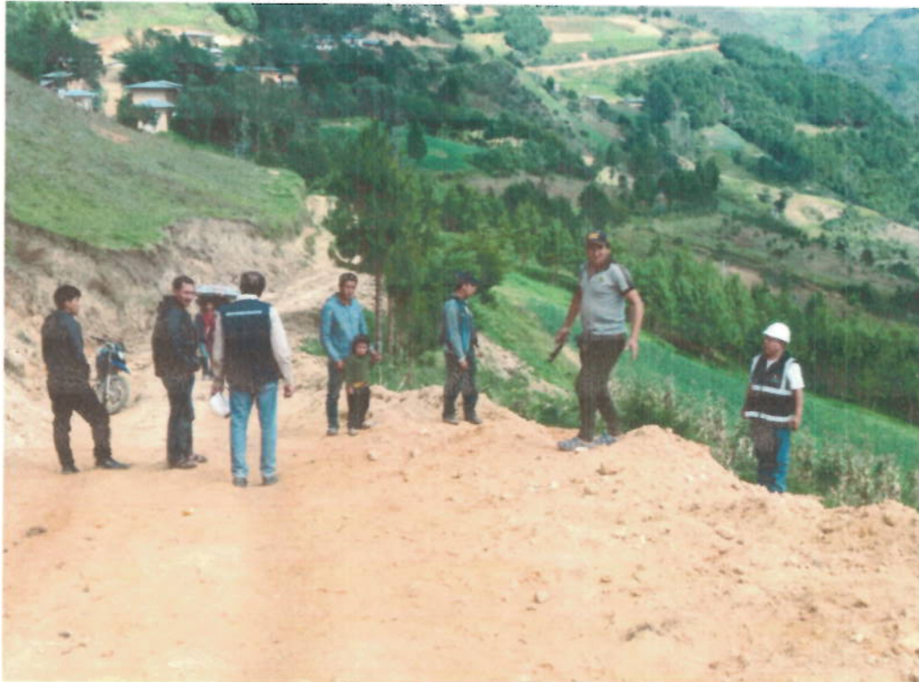
Foto N° 02.- Llegando al caserio de Candén, definiendo el ancho de vía, frente al área de su futura Posta
