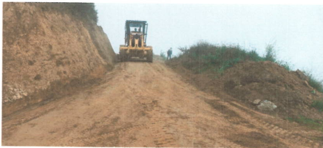
Foto N° 08.- Motoniveladora trabajando antes del desvío a Canden
