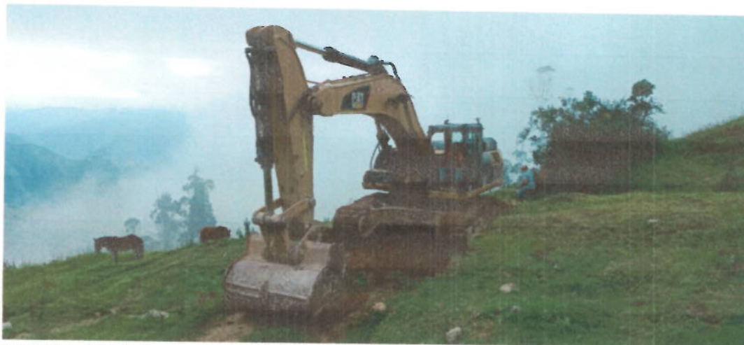
Foto N° 06.- Trabajando corte camino a Tres Cruces
