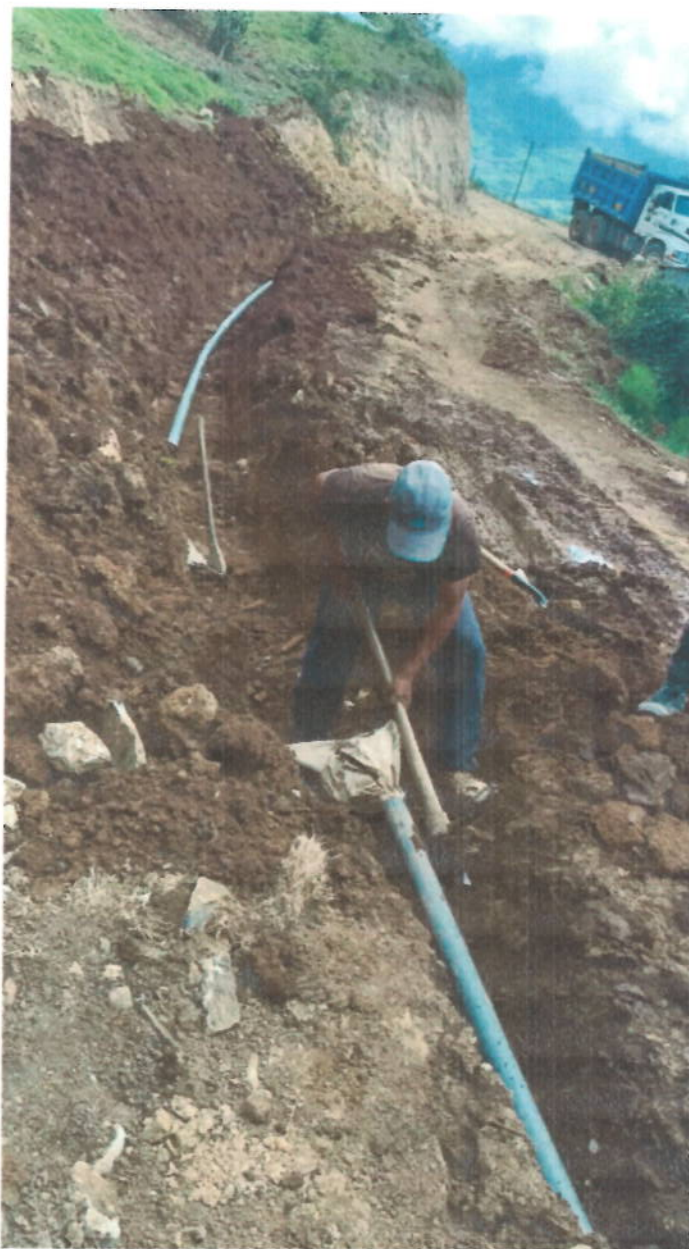
Foto N° 05.- Enterrando tubería paralela a la cuneta en otro sector
