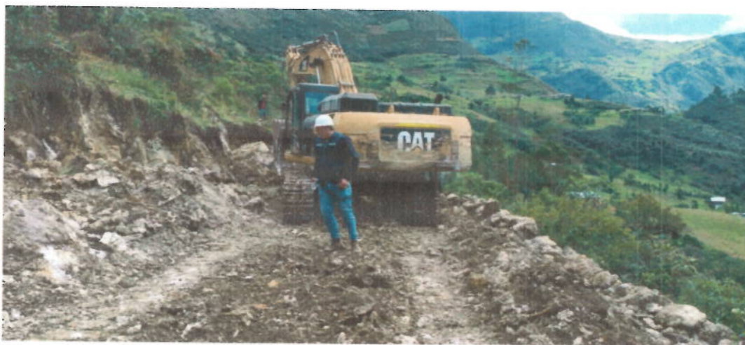
Foto N° 07.- Trabajando relleno con dirección a Tres Cruces
