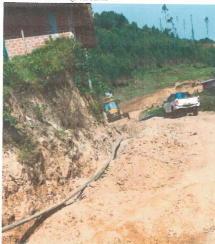
Foto N° 04.- Tubería que va a ser enterrada paralela a la cuneta
