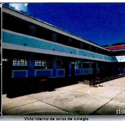
Vista interna de aulas de colegio
