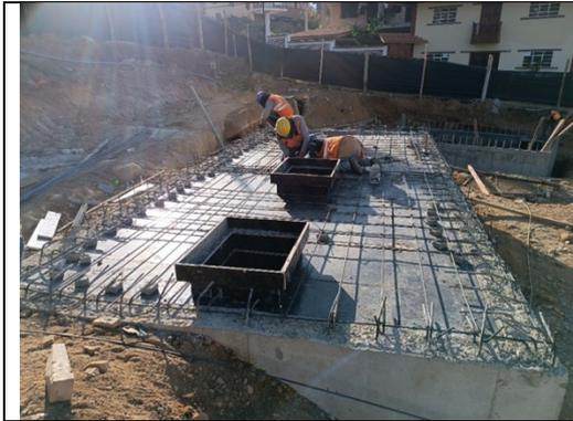
Acero en losas llenas de tanque séptico.
