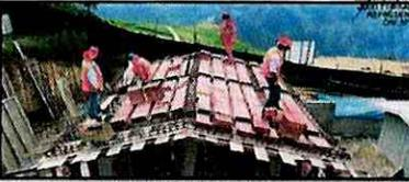
**FIGURA N° 64: Colocación de ladrillo techo y acero en Módulo "C"**
