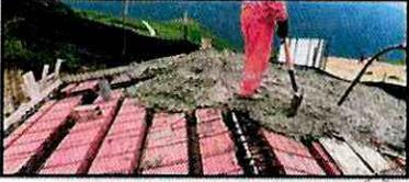
**FIGURA N° 63: Vaciado de aligerado Módulo "C"**
