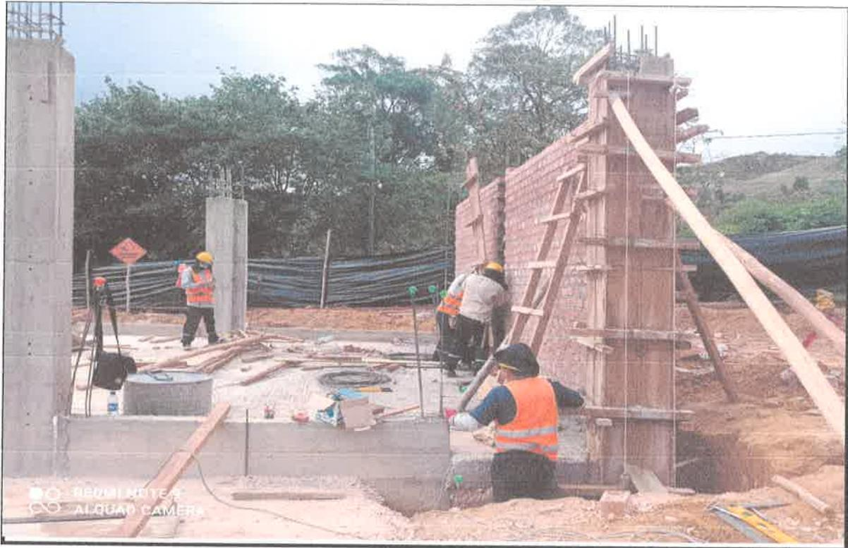
**FOTO N° 01: ENCOFRADO Y VACIADO DE CONCRETO EN COLUMNAS EN MODULO SUM**
