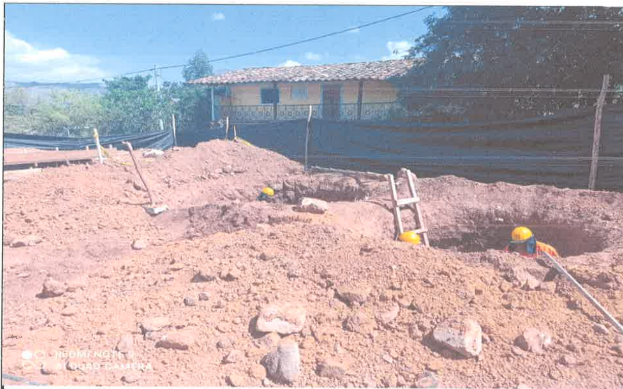
FOTO N° 13: EXCAVACIONES PARA LA INSTALACIÓN DE BIODIGESTOR Y POZO DE PERCOLACIÓN
