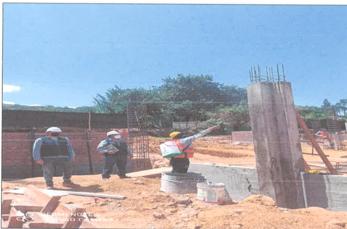
FOTO N° 14: CURADO DE CONCRETO EN COLUMNAS CON ADITIVO
