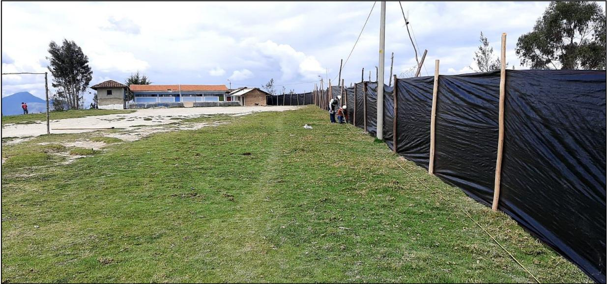
**Fotografía 03:** En la vista se aprecia al jefe de supervisión verificando la ejecución del cerco provisional de obra, delimitando de esta manera el área total destinada para la construcción de la obra.
