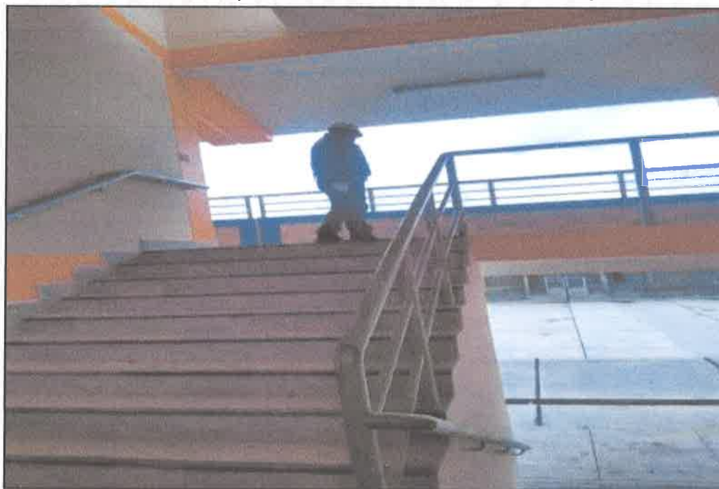
FOTOGRAFIA 2: VERIFICACION DEL PINTADO DE MUROS EXTERIORES.
