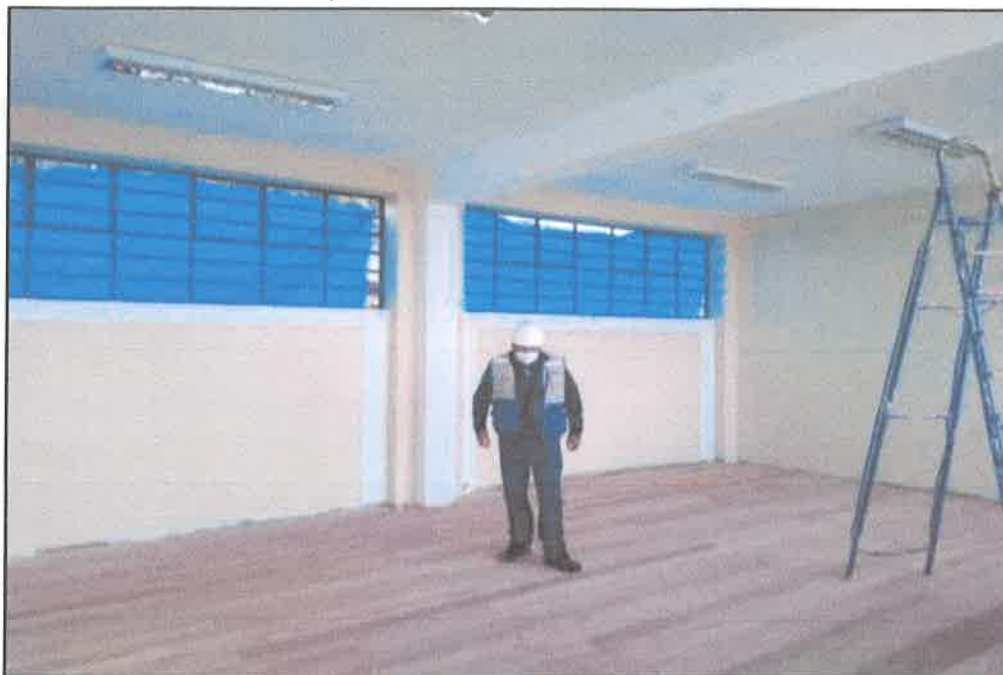
FOTOGRAFIA 1: VERIFICACION DE LA COLOCACION DEL MACHIMBRADO.
