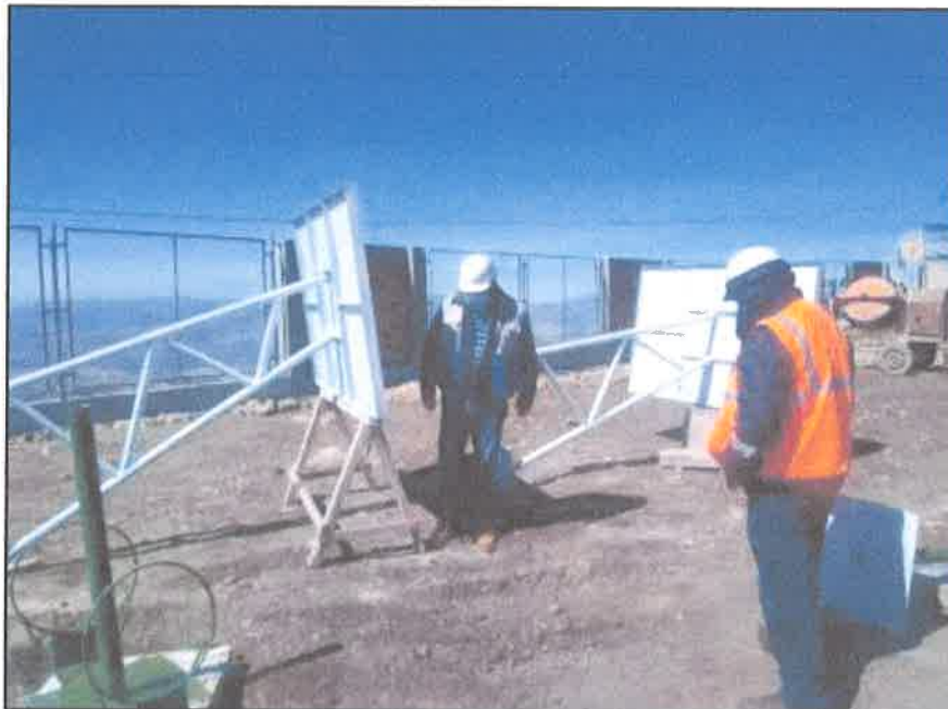
FOTOGRAFIA 2: VERIFICACION DEL PINTADO DE ARCOS PARA CAMPO DEPORTIVO
