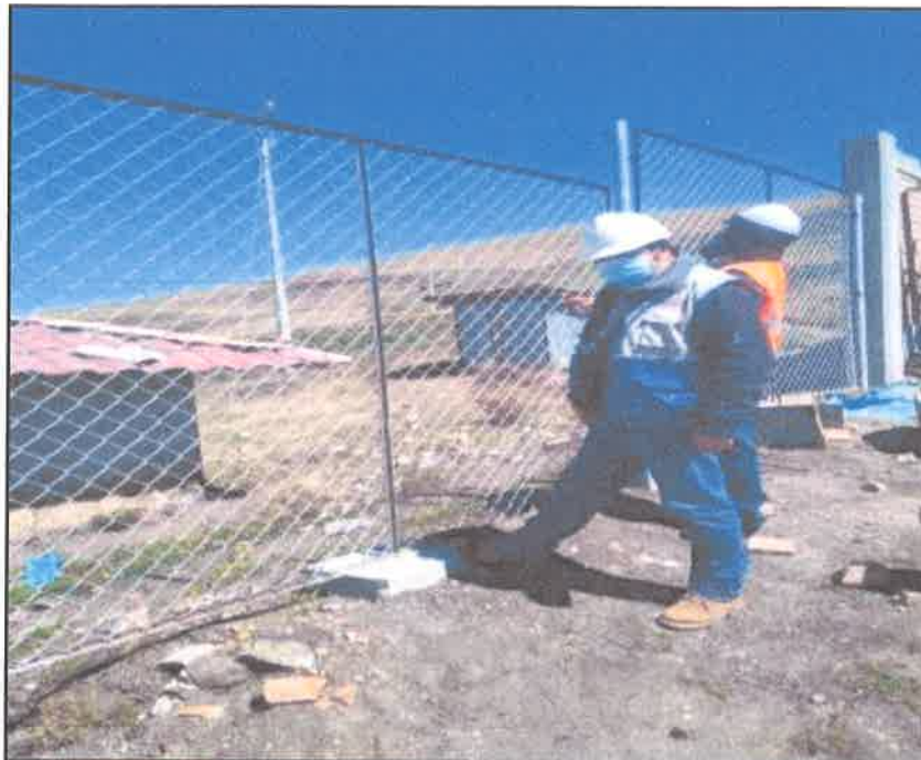
FOTOGRAFIA 1: VERIFICACION DE REFORZAMIENTO DE MALLA OLIMPICA
