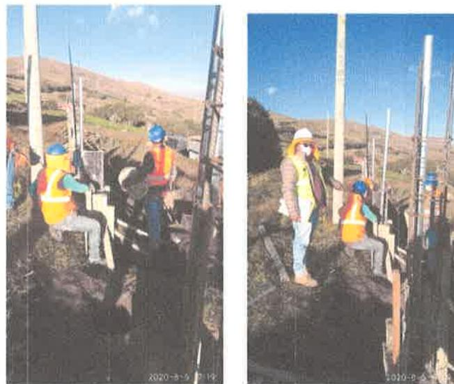
**FOTO 6: ENCOFRADO Y CONCRETO EN COLUMNAS DEL CERCO PERIMETRICO -- PARA SOPORTE DE TUBO DE MALLA**
