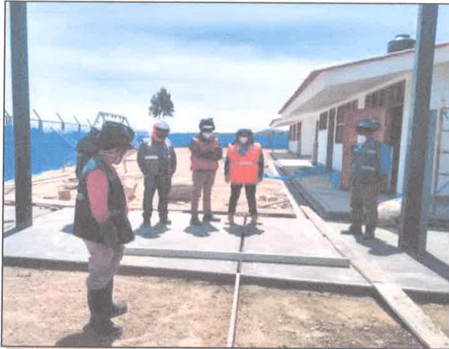
FOTOGRAFIA 1: VERIFICACION DE LA NIVELACION DE PATIO DE FORMACION
