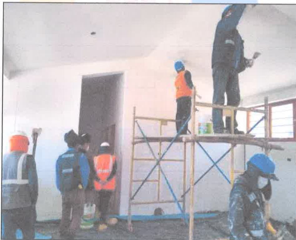
FOTOGRAFIA 2: VERIFICACION DEL EMPASTADO DE PAREDES
