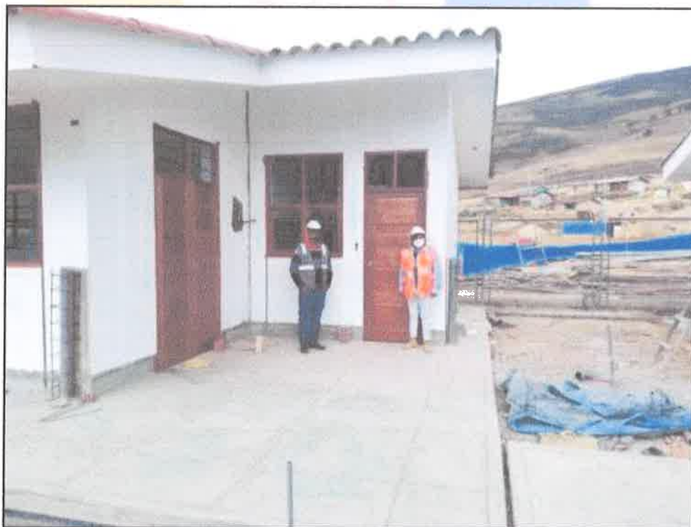
FOTOGRAFIA 2: VERIFICACION CONJUNTAMENTE CON EL INGENIERO ASISTENTE DE SUPERVISION DE LOS TRABAJOS EN VEREDAS
