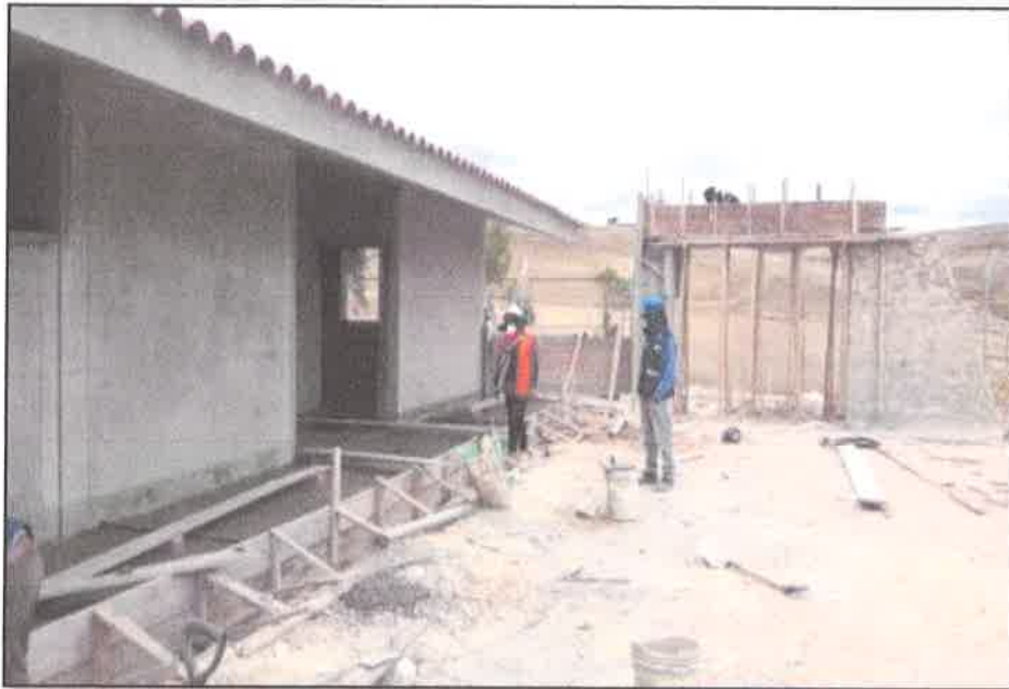
FOTOGRAFIA 1: VERIFICACION DE TRABAJOS EN VEREDAS
