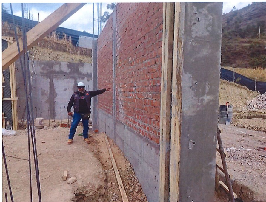
IMAGEN 05: TRABAJOS DE ASENTADO DE LADRILLOO DE CABEZA EN LOS MODULOS DE AULAS
