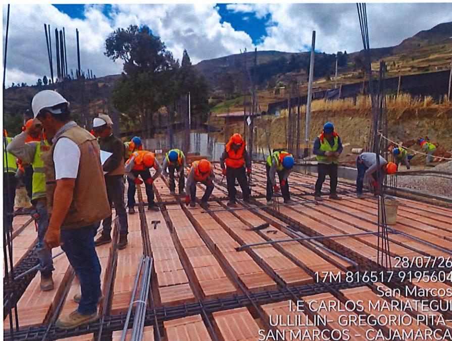
IMAGEN 21: TRABAJOS DE COLOCACION DE LADRILLO DE TECHO Y VACEADO DE CONCRETO EN LOSA ALIGERADA EN MODULO AULAS
