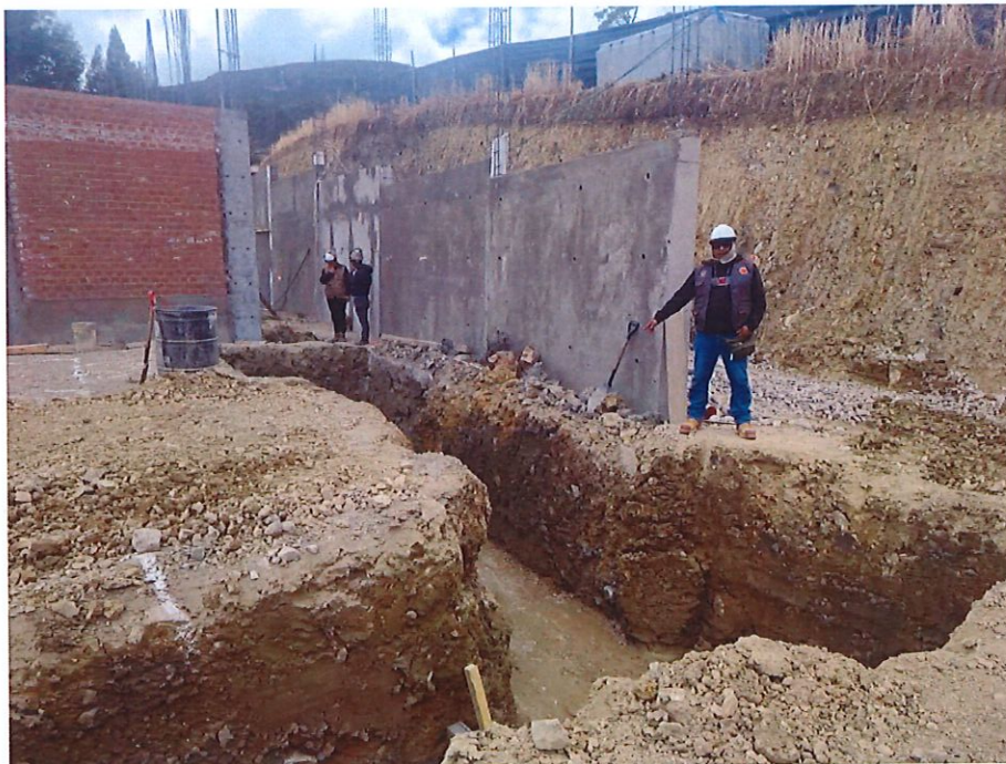
IMAGEN 14: TRABAJOS DE EXCAVACION NIVEL DE CIMENTACION EN MODULO AULAS
