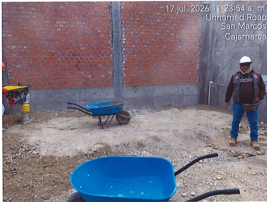
IMAGEN 11: TRABAJOS DE RELLENO Y COMPACTADO EN LOS MODULOS DE AULAS
