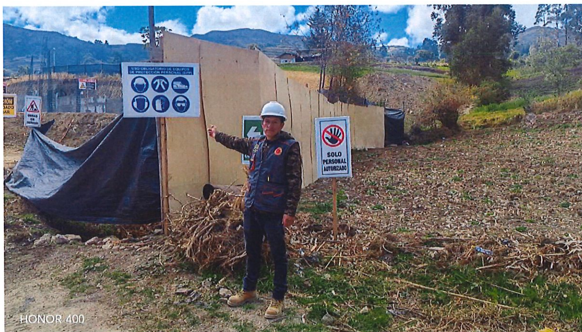
IMAGEN 34: TRABAJOS DE SEÑALIZACION EN OBRA
