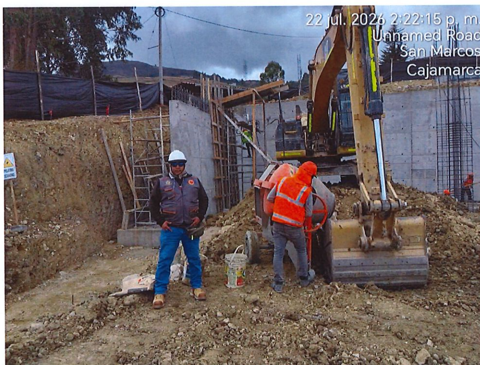
IMAGEN 10: TRABAJOS DE VACEADO DE CONCRETO FC=210 KG/CM2 EN MURO DE CONTENCION
