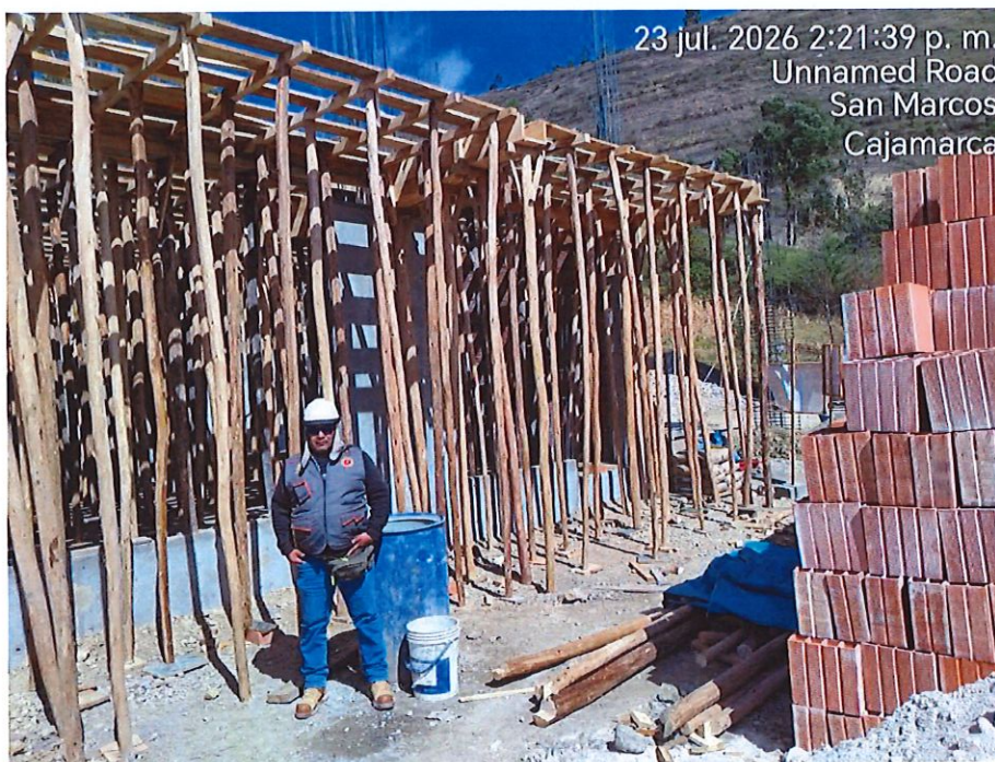
IMAGEN 19: TRABAJOS DE ENCOFRADO DE LOSA ALIGERADA EN MODULO AULAS
