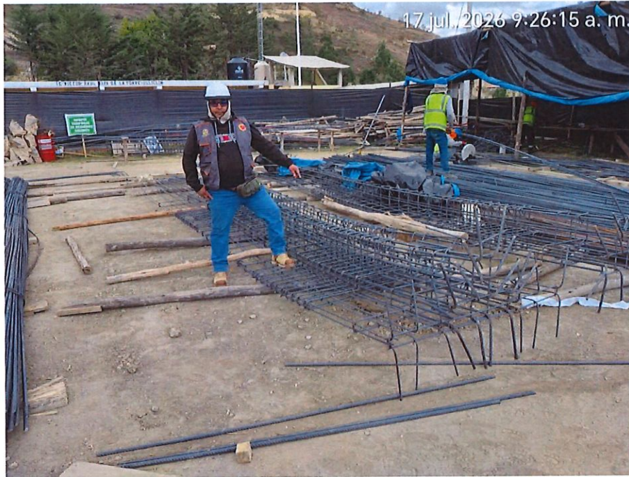
IMAGEN 27: TRABAJOS DE HABILITACION DE ACERO
