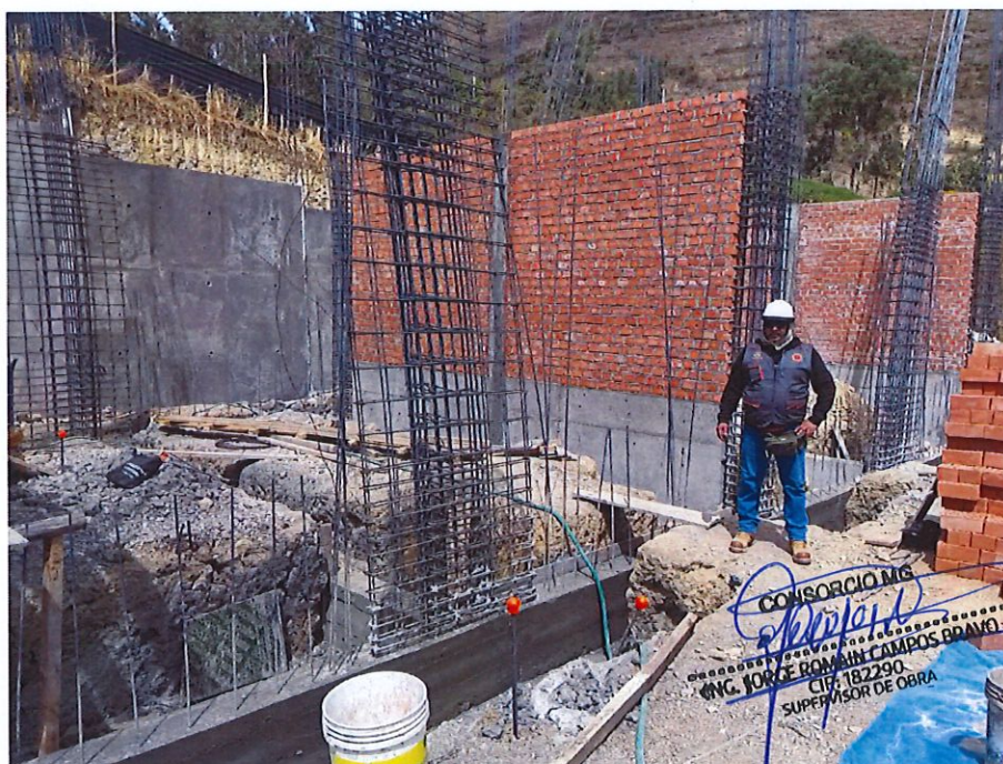
IMAGEN 08: TRABAJOS DE ARMADO DE ACERO EN VIGAS DE CONEXIÓN Y SOBRECIMIENTO ARMADO EN MODULO DE AULAS
