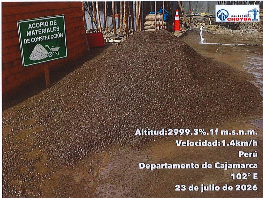
IMAGEN 31: ACOPIO DE MATERIAL EN OBRA
