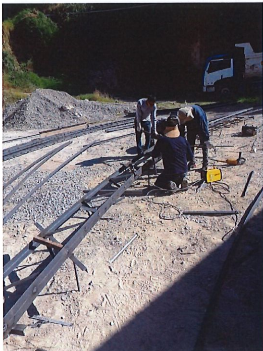
IMAGEN 39: TRABAJOS DE HABILITACION DE ESTRUCTURA METALICA DIAGONALES, BRIDAS SUPERIOR E INFERIOR, ENLACES, PERNOS DE ANCLAJES SEGÚN EL GRADO DE FLUENCIA DEL EXPEDIENTE TECNICO
