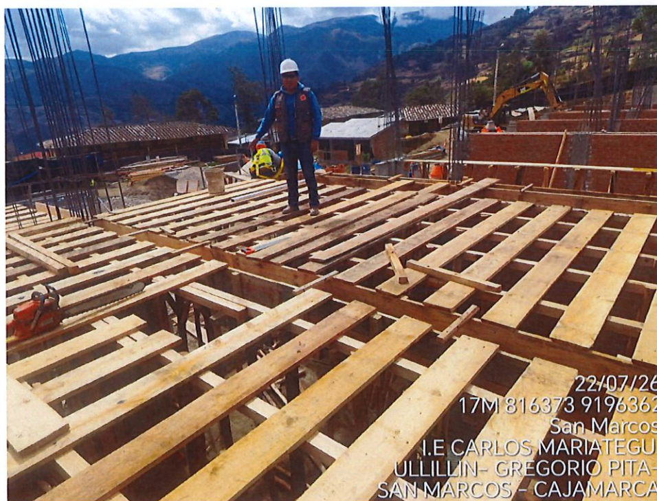
IMAGEN 20: TRABAJOS DE ENCOFRADO EN LOSA ALIGERADA EN MODULO DE AULAS
