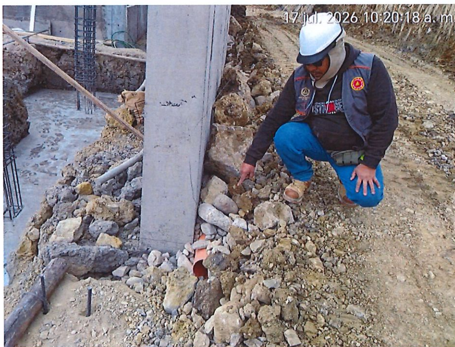
IMAGEN 24: TRABAJOS DE RELLENO Y COMPACTADO DE MATERIAL AFIRMADO EN LA PARTE POSTERIOR DEL MURO DE CONTENCIÓN COLOCACION DE LA TUBERIA PERFORADA DE 6"
