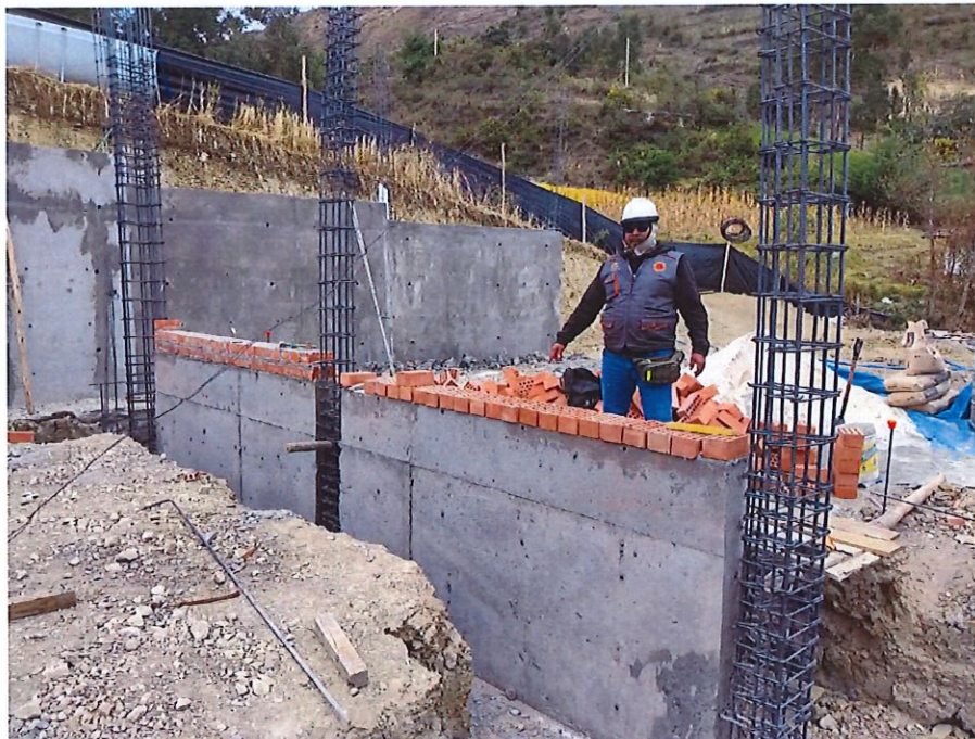
IMAGEN 01: ASENTADO DE LADRILLO KING KONG TIPO IV DE SOGA EN MODULOS DE LAS AULAS
