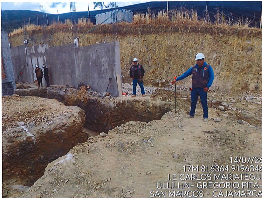
IMAGEN 16: TRABAJOS DE MEJORAMIENTO EN LAS AULAS DEL MODULO A MODULO C CON SU RESPECTIVO MEJORAMIENTO DE SUELO Y COMPACTADO
