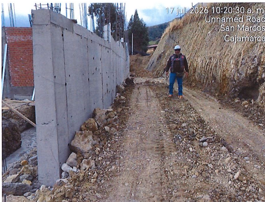
IMAGEN 23: TRABAJOS DE RELLENO Y COMPACTADO DE MATERIAL AFIRMADO EN LA PARTE POSTERIOR DEL MURO DE CONTENCIÓN
