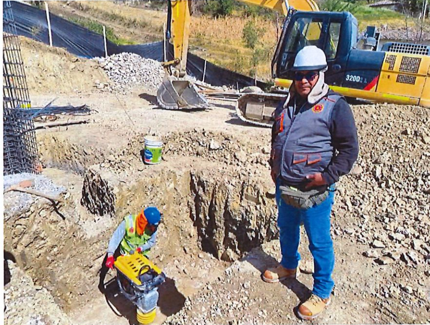
IMAGEN 15: TRABAJOS DE MEJORAMIENTO EN LAS AULAS DEL MODULO A MODULO C CON SU RESPECTIVO MEJORAMIENTO DE SUELO Y COMPACTADO
