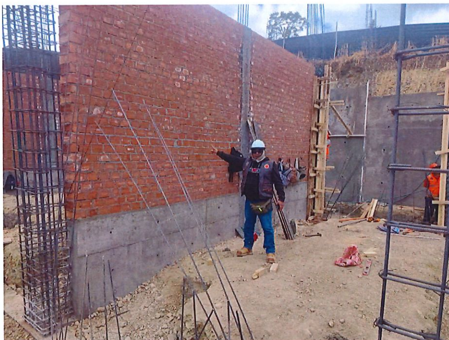
IMAGEN 06: TRABAJOS DE ASENTADO DE LADRILLO DE CABEZA EN MODULO DE AULAS
