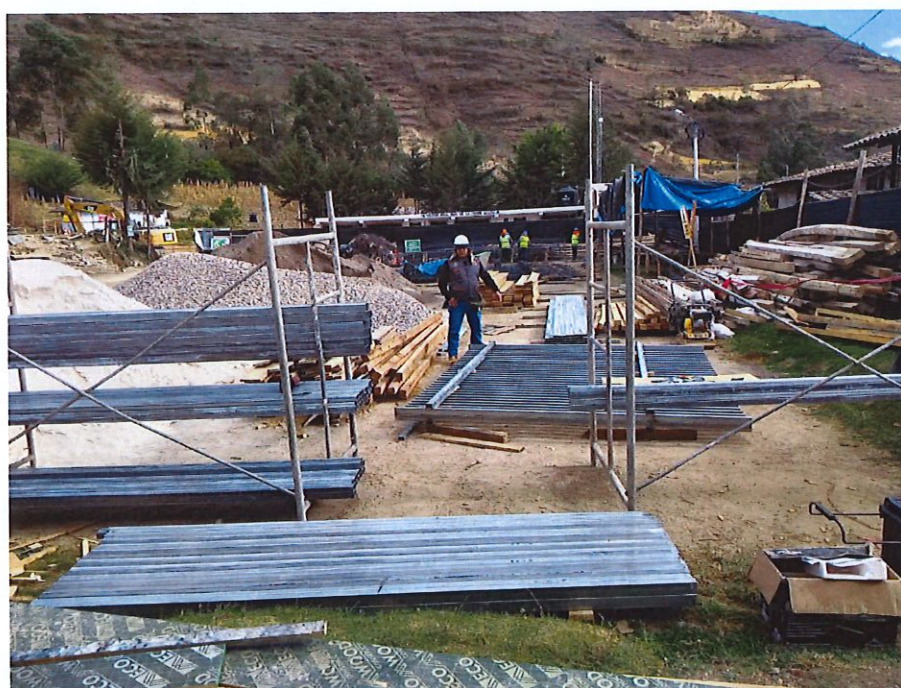
IMAGEN 36: TRABAJOS DE HABILITACION DE ESTRUCTURA METALICA PERFILES PARA CERCO PERIMETRITO Y COBERTURA EN LOSA DEPORTIVA
