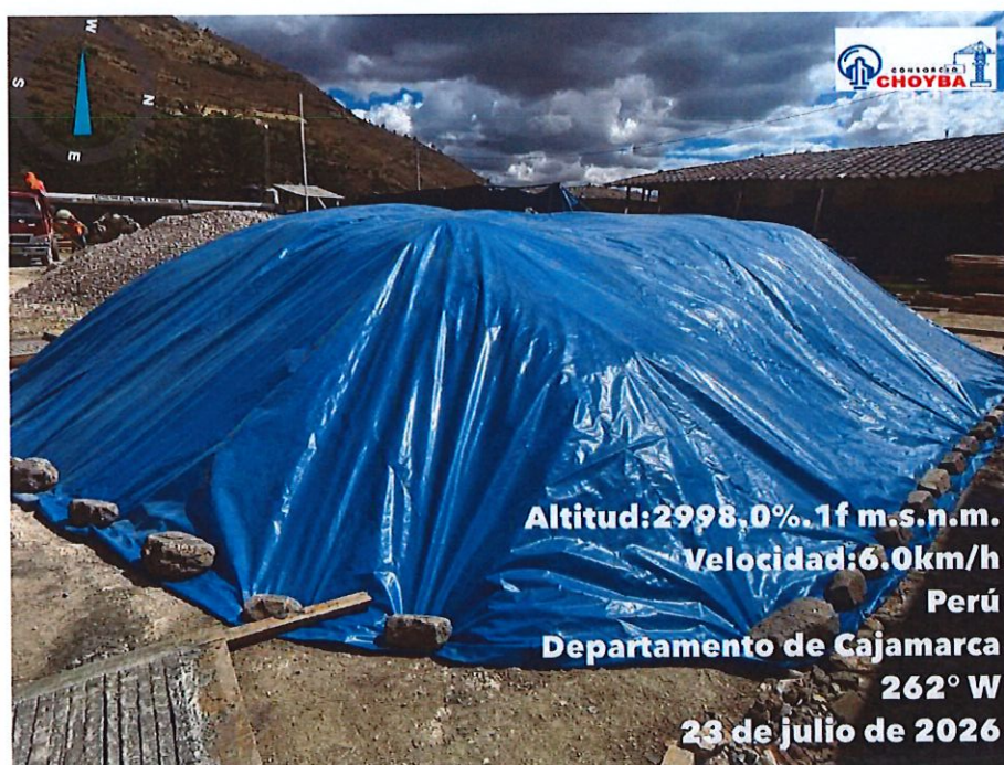
IMAGEN 30: TRABAJOS DE CUBRIR EL MATERIAL PARA EVITAR LAS LLUVIAS
