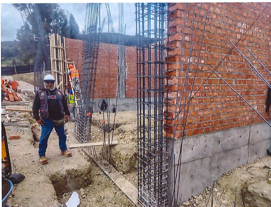
IMAGEN 04: TRABAJOS DE ARMADO Y ENCOFRADO EN PLACAS EN LOS MODULOS DE AULAS
