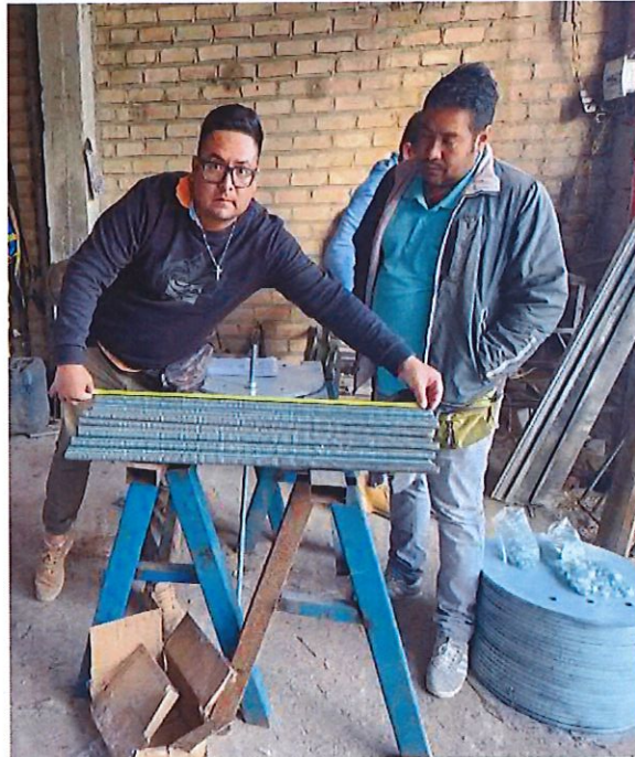
IMAGEN 37: TRABAJOS DE HABILITACION DE ESTRUCTURA METALICA DIAGONALES, ENLACES, PERNOS DE ANCLAJES SEGÚN EL GRADO DE FLUENCIA DEL EXPEDIENTE TECNICO
