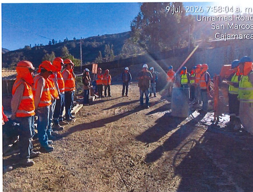
IMAGEN 18: TRABAJOS DE HABILITACION DE ACERO
