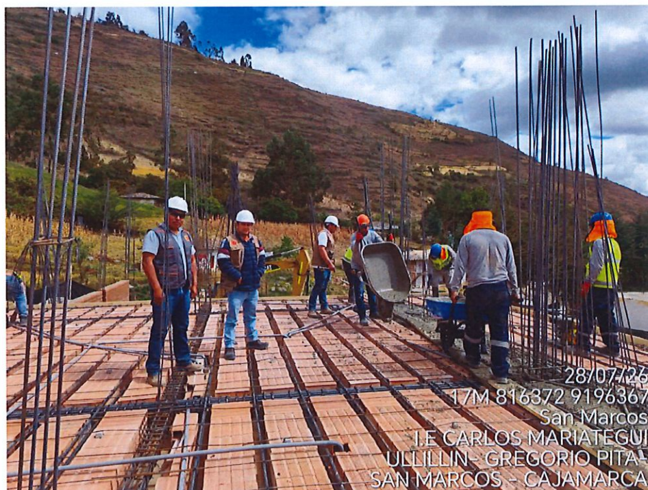
IMAGEN 22: TRABAJOS DE COLOCACION DE LADRILLO DE TECHO Y VACEADO DE CONCRETO EN LOSA ALIGERADA EN MODULO AULAS
