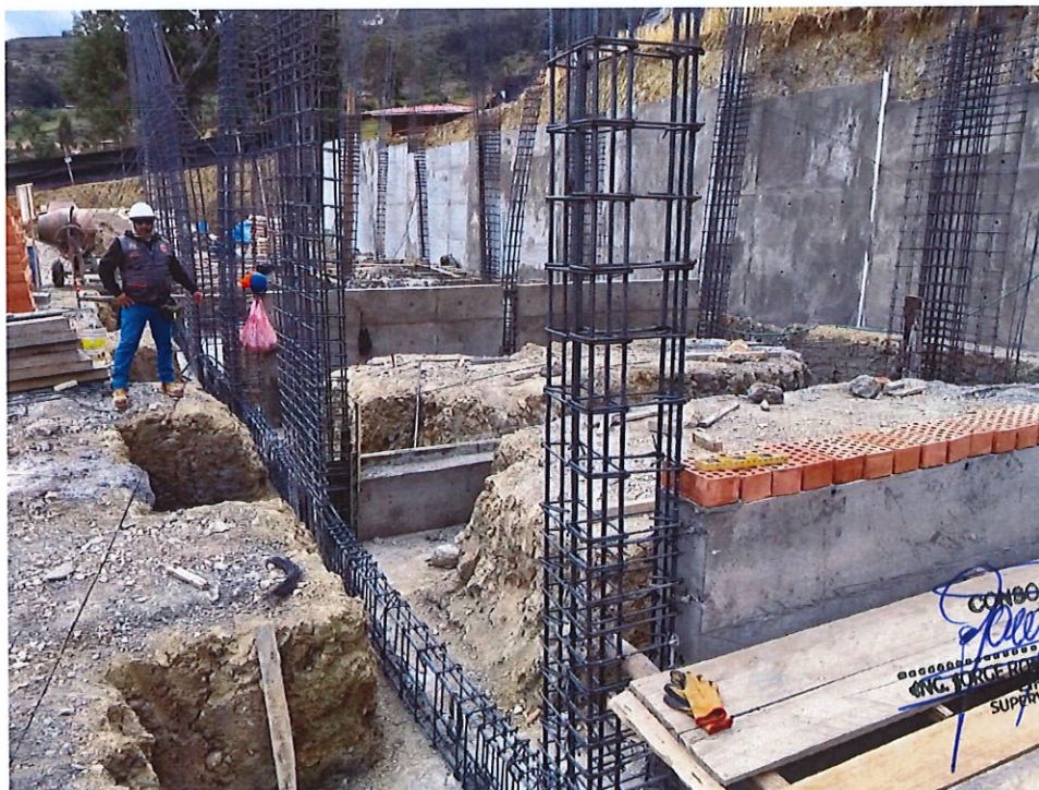
IMAGEN 02: INSPECCIÓN TÉCNICA REALIZADA POR EL SUPERVISOR CON EL IZADO, COLOCACIÓN DE ACERO Y VACIADO CON CONCRETO F'C=210 KG/CM2 EN CIMENTACIÓN CORRIDA.
