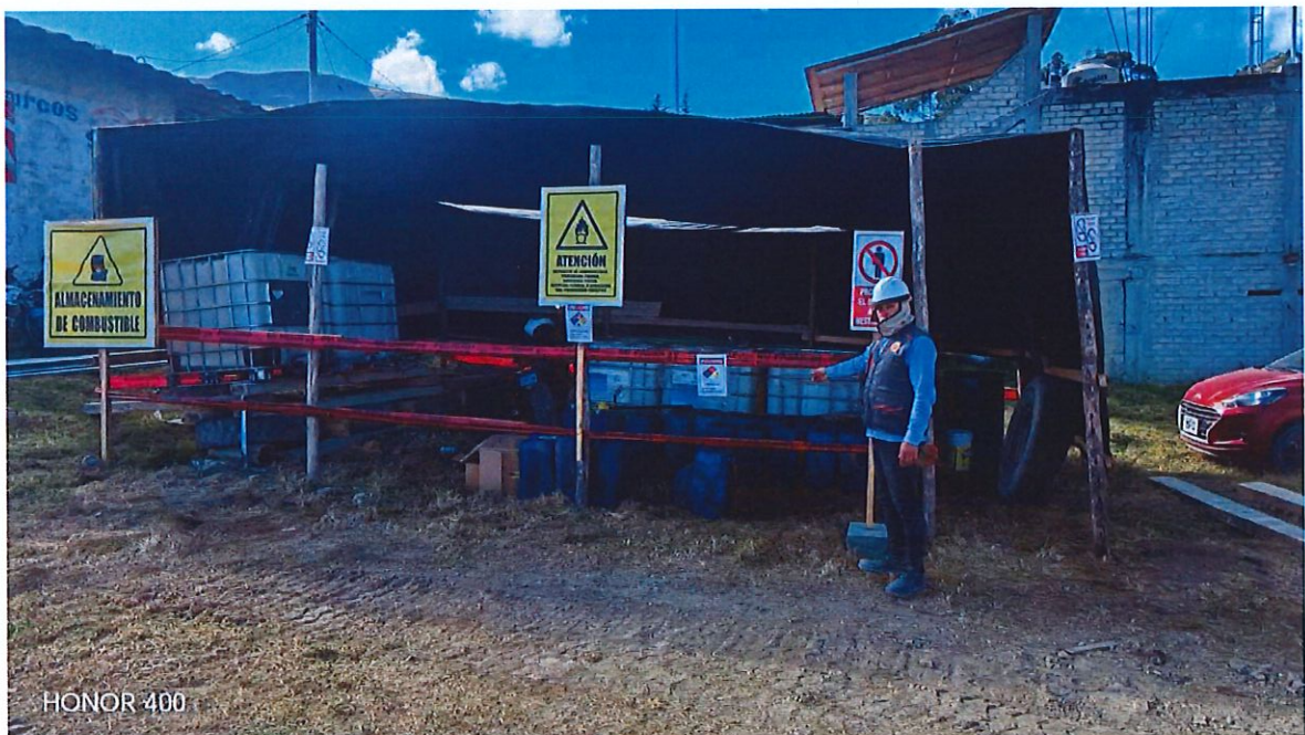
IMAGEN 32: TRABAJOS DE SEÑALIZACION EN OBRA
