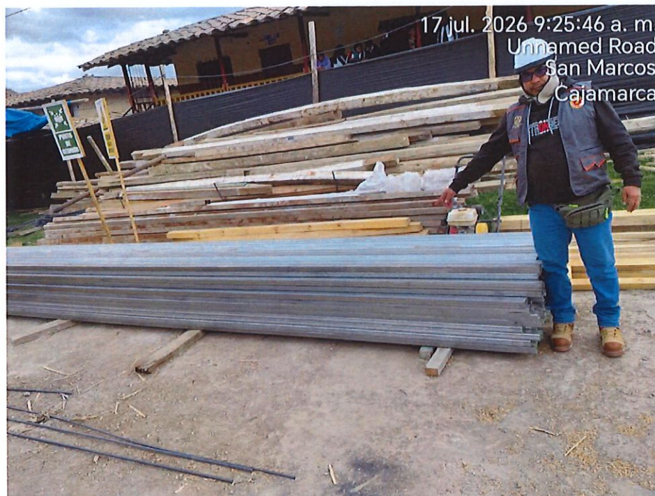
IMAGEN 35: TRABAJOS DE HABILITACION DE ESTRUCTURA METALICA PERFILES PARA CERCO PERIMETRITO Y COBERTURA EN LOSA DEPORTIVA
