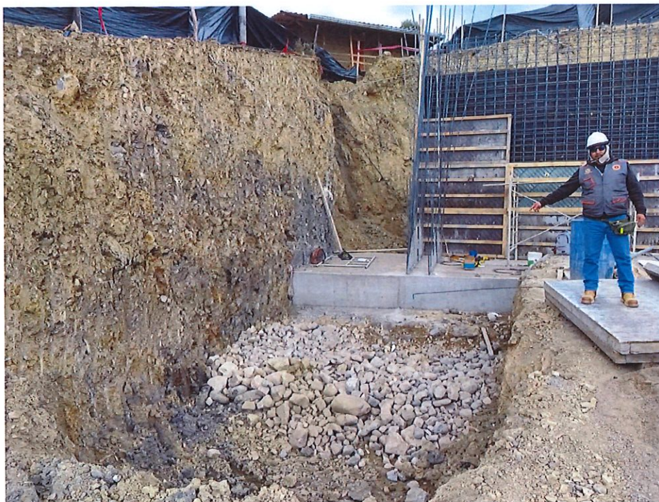
IMAGEN 09: TRABAJOS DE MEJORAMIENTO ENCOFRADO Y VACEADO DE CONCRETO EN MURO DE CONTENCION
