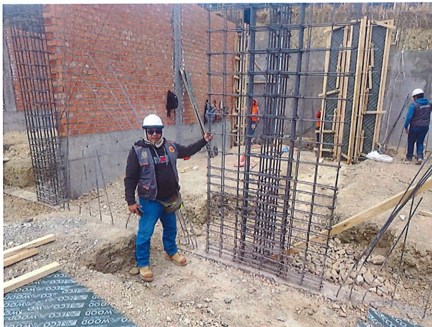
IMAGEN 03: TRABAJOS DE ARMADO Y ENCOFRADO EN PLACAS EN LOS MODULOS DE AULAS
