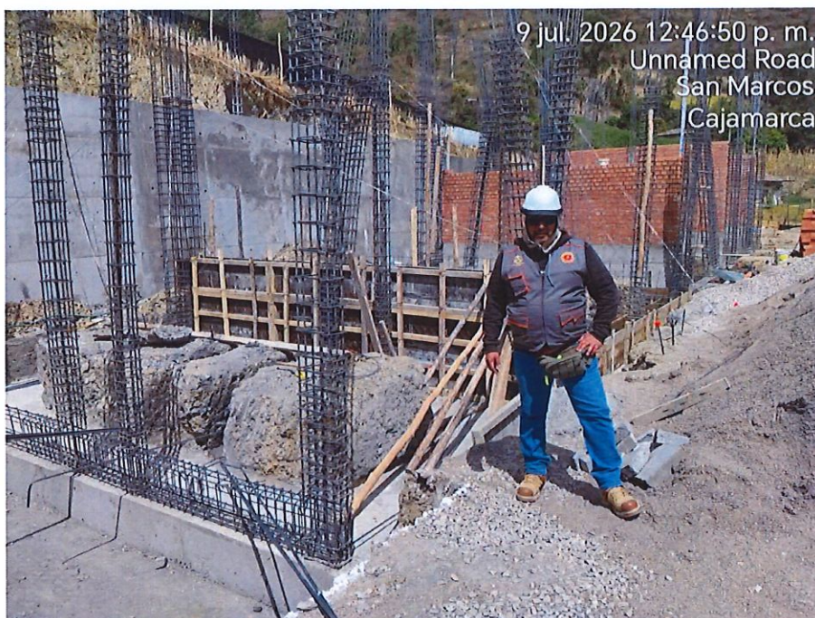
IMAGEN 07: TRABAJOS DE ARMADO DE ACERO EN VIGAS DE CONEXIÓN Y SOBRECIMIENTO ARMADO EN MODULO DE AULAS
