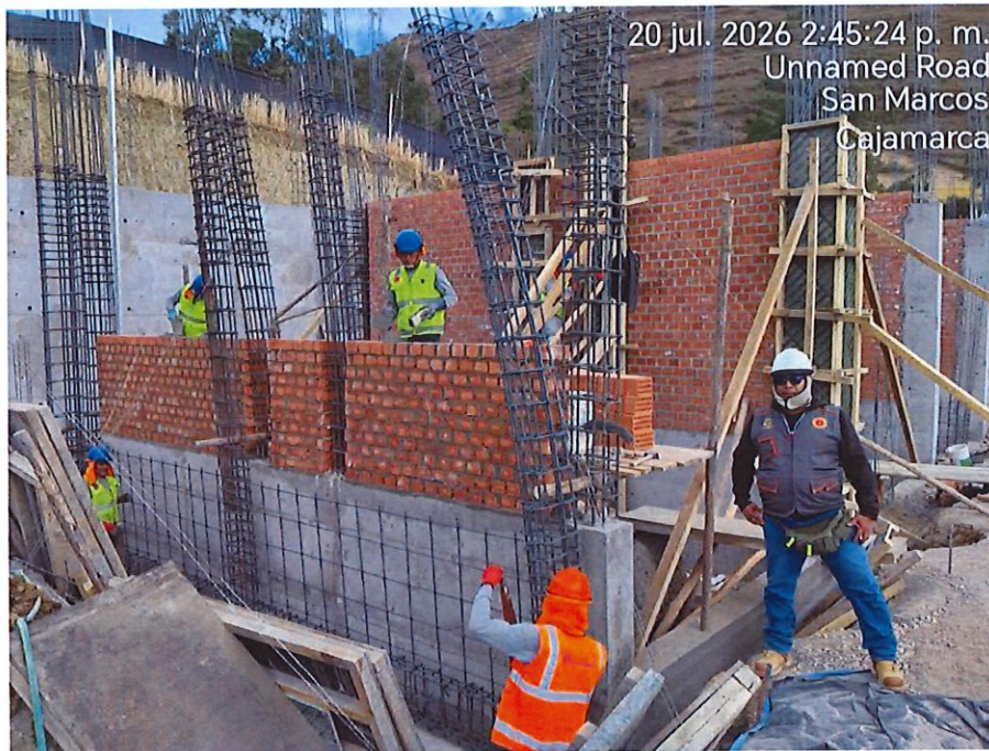
IMAGEN 13: TRABAJOS DE SOBRECIMIENTO ARAMADO Y ASENTADO DE LADRILLO EN MODULO AULAS
